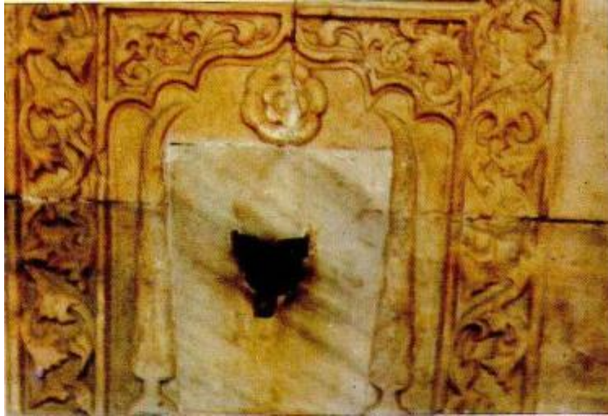
Fotoğraf 66. Hekimoğlu Ali Paşa Çeşmesi denize bakan cephe ayna taşı detay (Barişta, 1993: 42).
