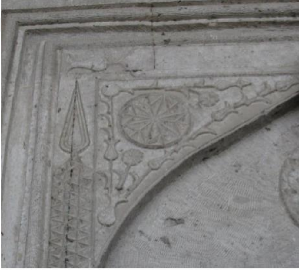
Fotoğraf 26. Kayseri Hasinli Camii giriş kapısı süsleme detayı (Atak, 2014: 912).
