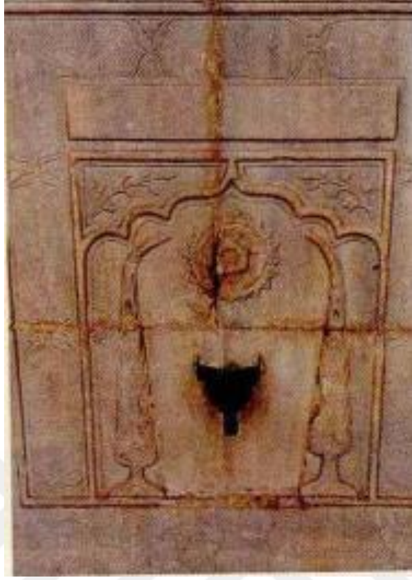
Fotoğraf 65. Hekimoğlu Ali Paşa Çeşmesi yola bakan cephe ayna taşı detay (Barişta, 1993: 32).
