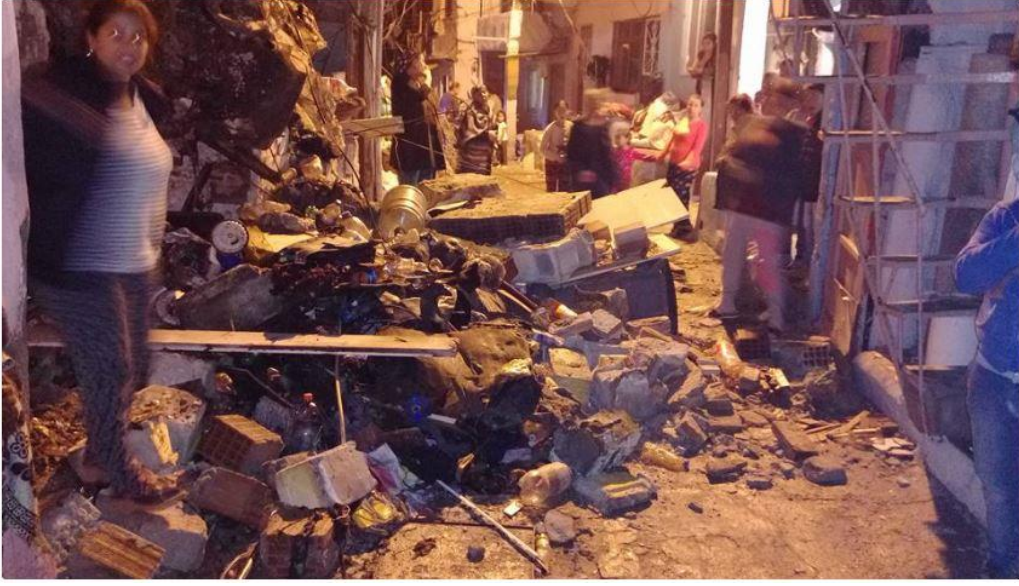
Şekil 14: Fevzipaşa mahallesinde çöken bir ev
