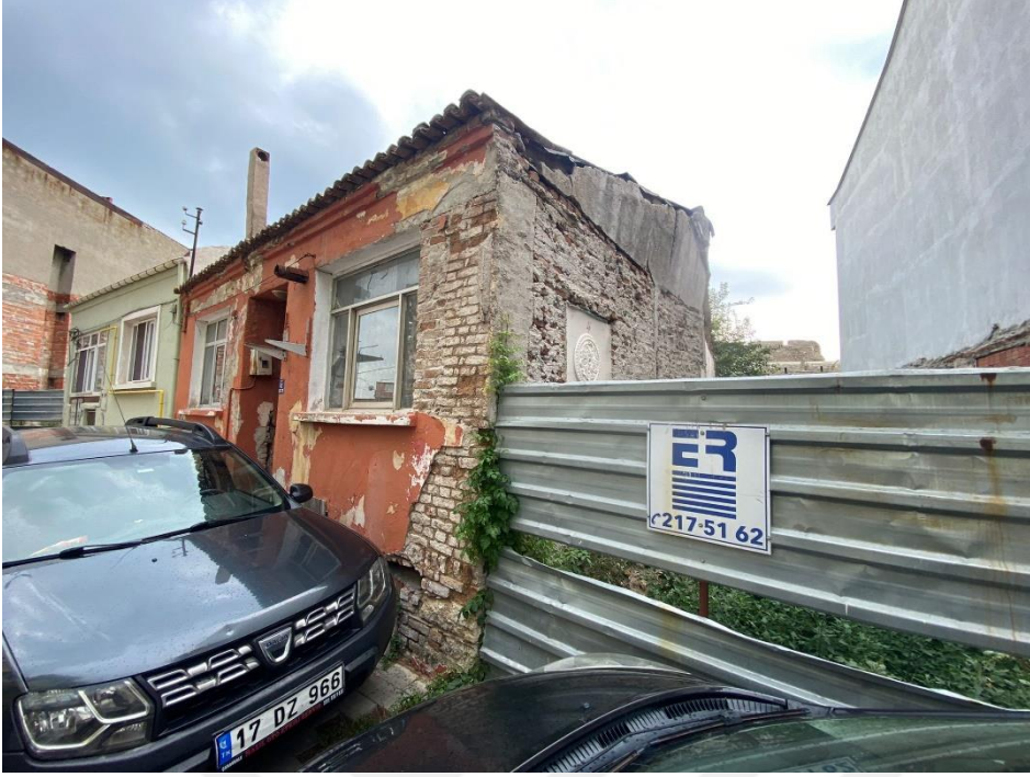
Şekil 16: Erdemir İnşaat proje alanı
