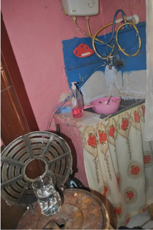
Şekil 13: Fevzipaşa Mahallesi iç mekân durumu örneği
