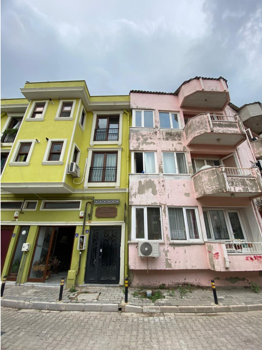
Şekil 27: 2014'ten sonra mahallede inşa edilen yeni yapı ve eski yapı
