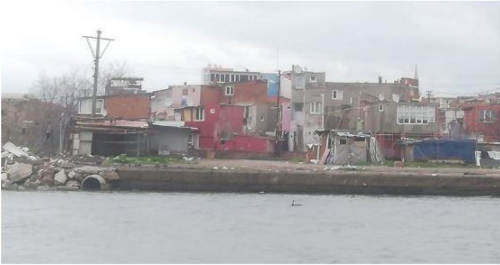
Şekil 15: Fevzipaşa mahallesinin çöküntü hali
