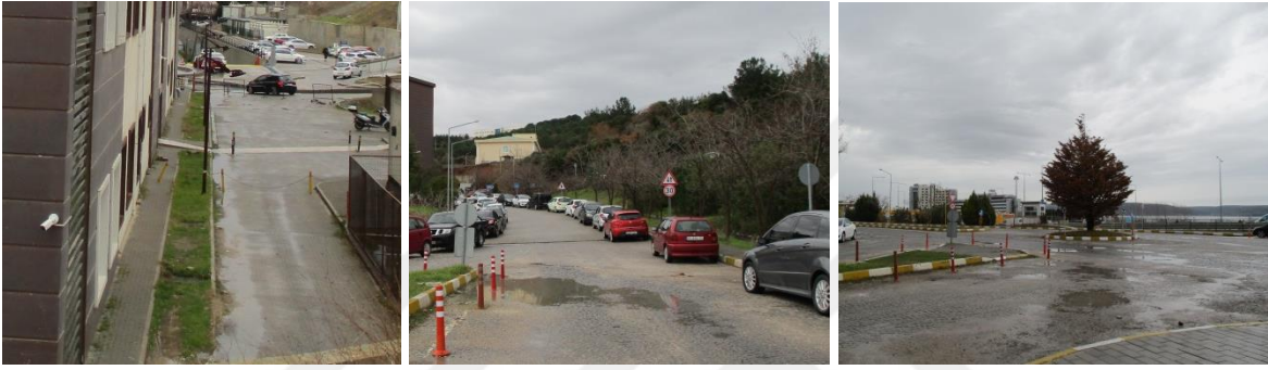
Şekil 53. Hastane bölgesinde yollarda oluşan su birikintileri (Orijinal, 2022)
