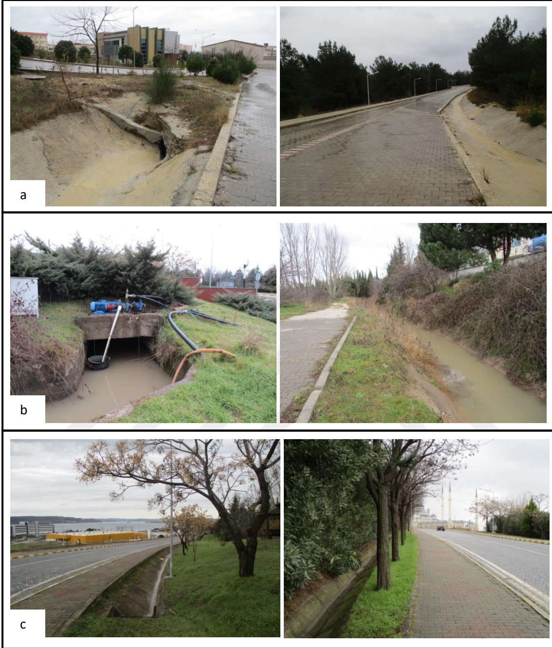
Şekil 43. Yağmurlu bir günde Terzioğlu Yerleşkesi'nde bulunan açık drenaj kanallarındaki yüzeysel akış. (a) Safiye Hüseyin Elbi KYK Yurdu'ndan inen drenaj kanalı. (b) Çomü Kreş'in yanında bulunan drenaj kanalı. (c) Terzioğlu Yerleşkesi ana giriş yolu drenaj kanalı (Orijinal, 2022)
