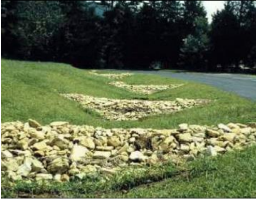
Şekil 6. Kontrol benti uygulanmış çim hendek örneği. “Iowa Storm Water Management Manual”, Iowa Department of Natural Resources, 2009, s. 17 kitabından alınmıştır.
