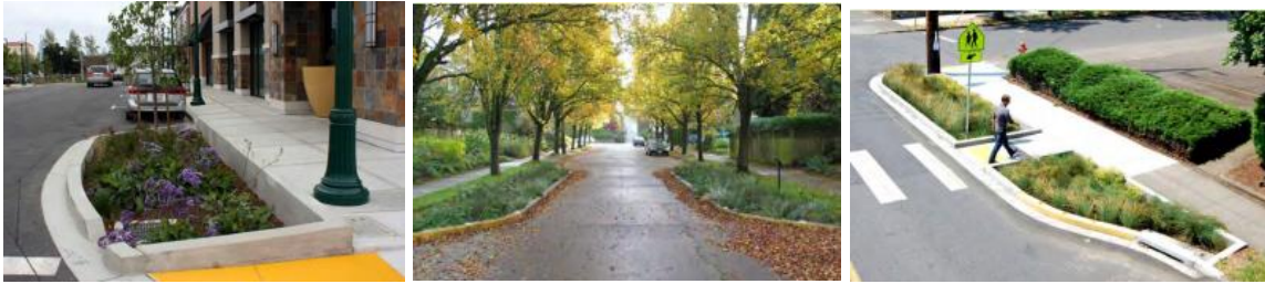
Şekil 10. Bordür uzantısı örnekleri. “Green Infrastructure Design Guide”, San Mateo Countywide Water Pollution Prevention Program, 2020, s. 44-45 kitabından alınmıştır.
