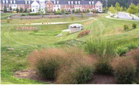
Şekil 16. Kuru gölet örneği. “Low Impact Development in Coastal South Carolina: A Planning and Design Guide”, Ellis vd., 2014, s. 166 kitabından alınmıştır.
