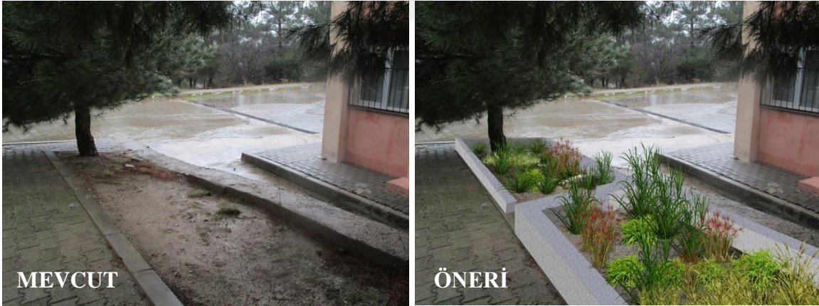
Şekil 64. Fen Edebiyat Fakültesi'nde teraslama yapılmış yağmur suyu bitki şeridi önerisi (Orijinal, 2022)
