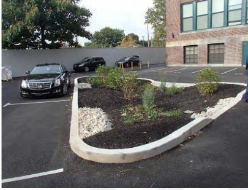
Şekil 12. Filtre şerit uygulama örneği. “Stormwater Management Guidance Manuel”, Philadelphia Water Department, 2020, s. 174 kitabından alınmıştır.
