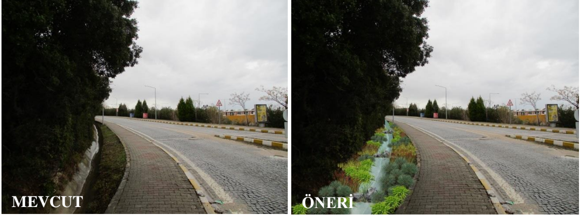
Şekil 59. Açık drenaj kanalında bitkilendirilmiş hendek önerisi (Orijinal, 2022)
