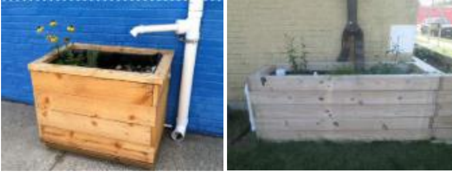
Şekil 18. Yağmur borusu bitki kutusu uygulaması. “Green Infrastructure Guidance Manual for New Jersey”, Rutgers Cooperative Extension Water Resources Program, 2016, s. 28 kitabından alınmıştır.
