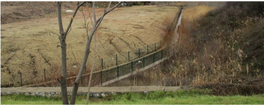
Şekil 54. Sarp Deresi taşkın kontrol yapısı (Orijinal, 2022)
