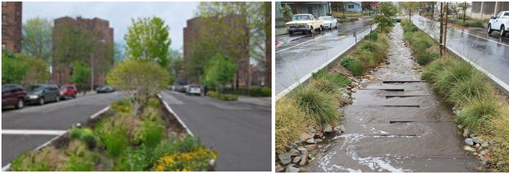
Şekil 5. Biyolojik hendek örnekleri. “The Sponge Handbook: Chennai”, Biswas vd., 2019, s. 29 kitabından alınmıştır.
