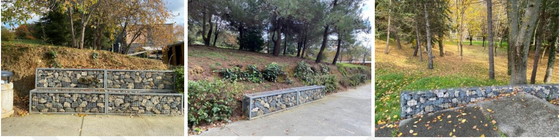
řekil 21. Gabion duvar uygulamaları (Orijinal, 2021)
