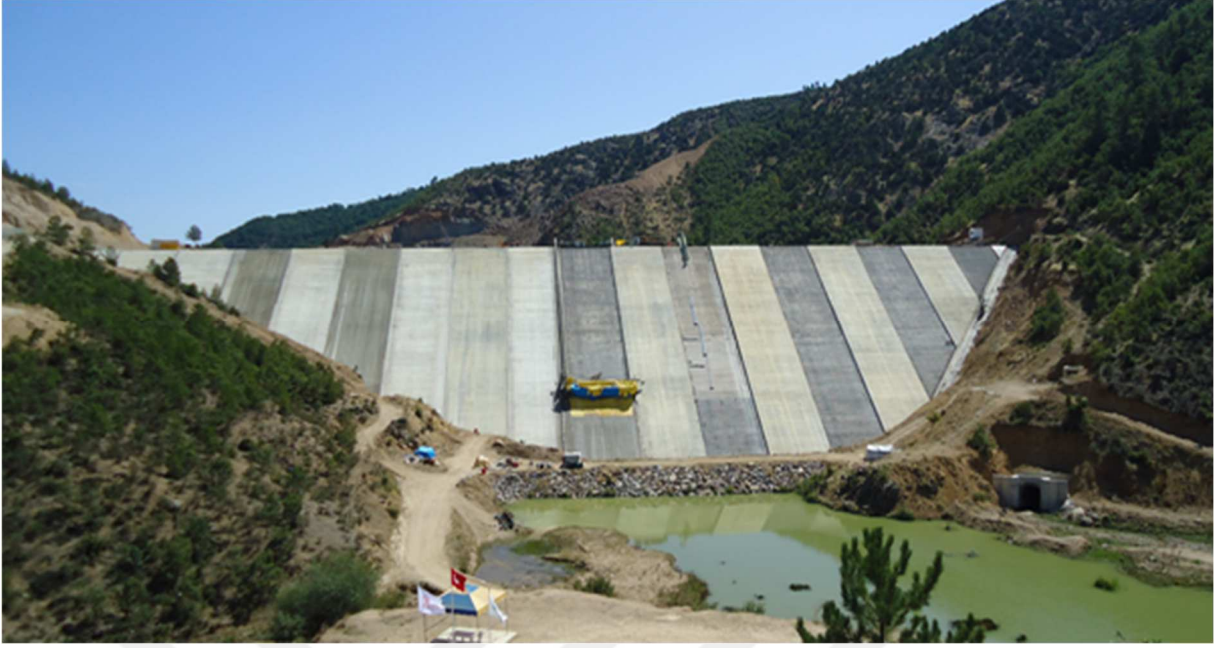
Şekil 16. Beton memba kaplamalı kaya dolgu barajı
