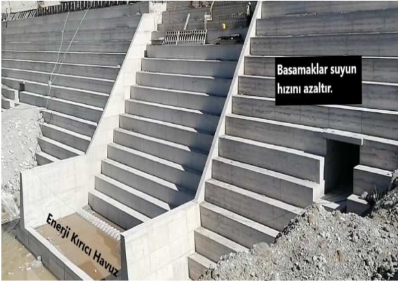
Şekil 10. Enerji Kırıcı Havuz
