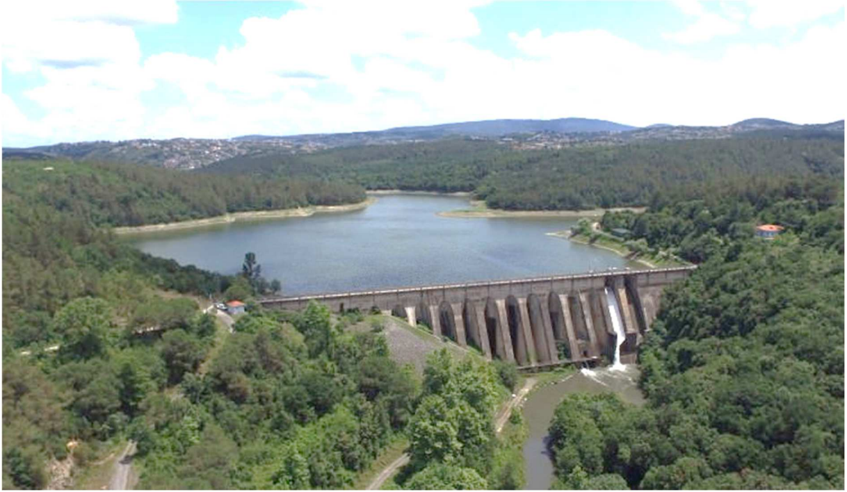
Şekil 20. Payandalı beton baraj (Elmalı Barajı)
