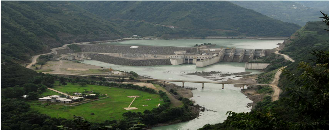
Şekil 17. Asfalt memba kaplamalı kaya dolgu barajı
