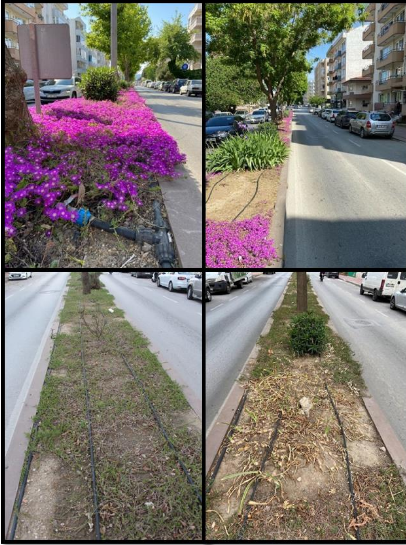
Şekil 32. 100. Yıl Caddesi refüjü üzerindeki damla sulama sistemi
