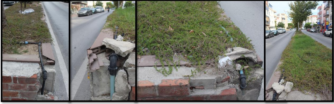
Şekil 33. Alandaki mevcut sulama borularının görüntüsü
