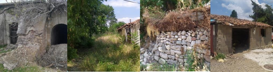
Şekil 5. Bolayır Köyü yol ve yapı mevcut durumu
