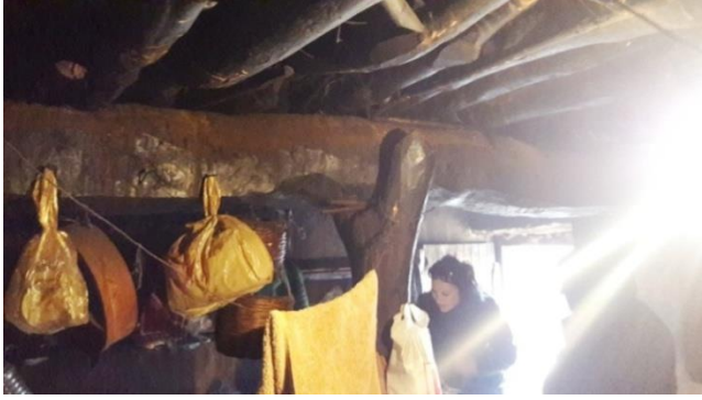
Şekil 17. Nene Evi Üst Örtüyü Taşıyan Ahşap Dikme ve Bu Dikme Üzerine Oturan Ahşap Kirişten Görünüm
