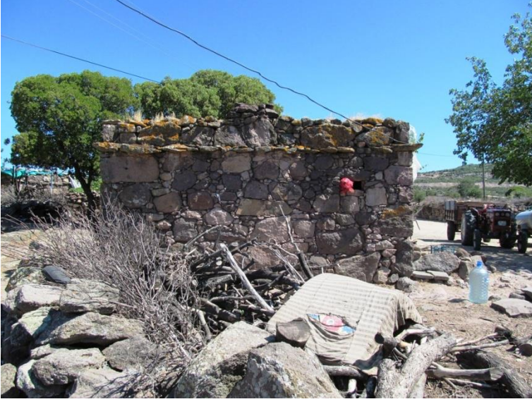
Şekil 13. Ünzile Vural'a ait Nene Evi Örneğinin Yan (Kuzey) Cephesinden Görünüm
