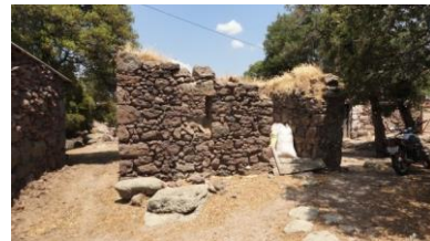
Nene Evi 8 Kullanım Durumu: Terkedilmiş / Sağlamlık Durumu: Harap
