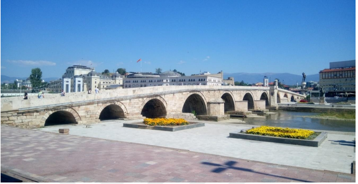
Şekil 1: Vardar Nehri üzerinde bulunan Fatih Sultan Mehmet Köprüsü (Taşköprü)
