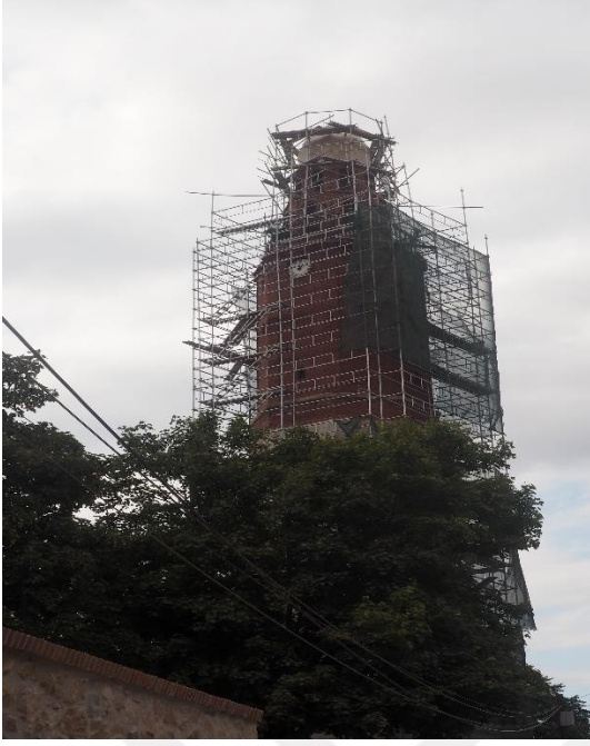
Şekil 22: Saat Kulesi- Saat Kule Mahallesi
