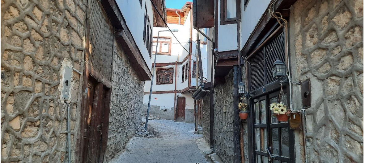
Şekil 25. Beypaazarı evleri kaba yonu zemin kat (Özgün, 2022)
