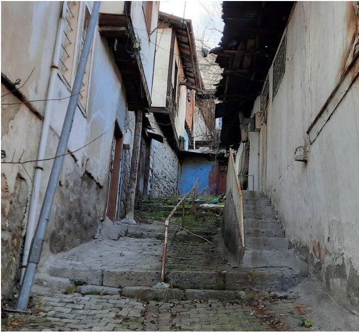
Şekil 41. Sokak arasında tahrip olmuş bir merdiven-rampa örneği (Özgün, 2022)
