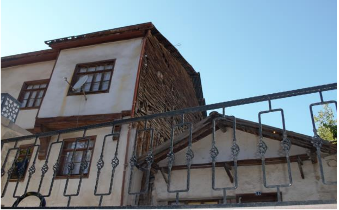
Şekil 20. Ahşap yapı iskeleti görünen bir konut örneği (Özgün, 2021)
