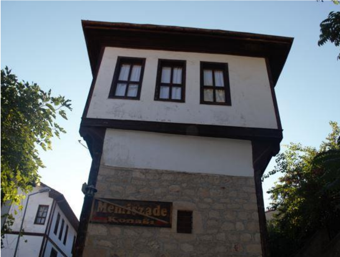
Şekil 24. Beypazarı evleri sıvasız kaba yonu zemin kat (Özgün, 2021)
