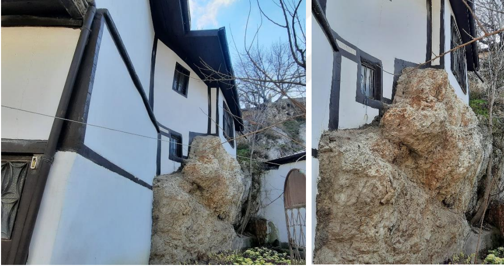
Şekil 54. Zemini kaya üzerine oturtulmuş Beypazarı evi (Özgün, 2022)
