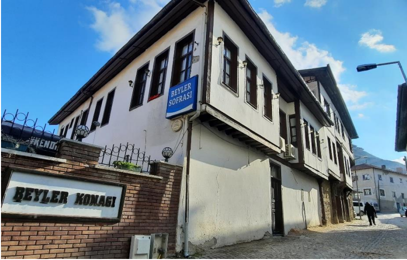
Şekil 22. 2 katlı Beypazarı evi örneği (Özgün, 2022)
