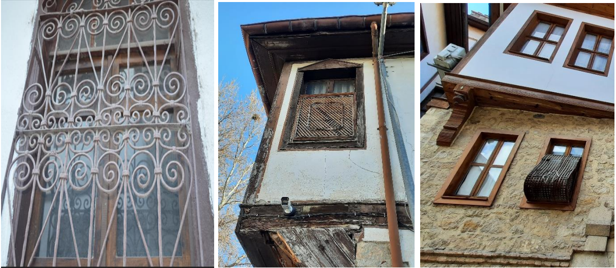
Şekil 30. Demir parmaklıklı veya ahşap kafesli pencereler (Özgün, 2022)
