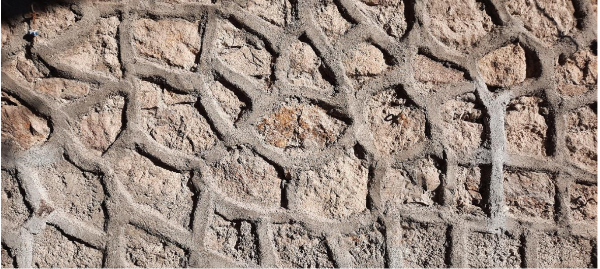
Şekil 26. Zemin katta kullanılan kaba yonu taş (kesme taş) malzeme (Özgün, 2022)
