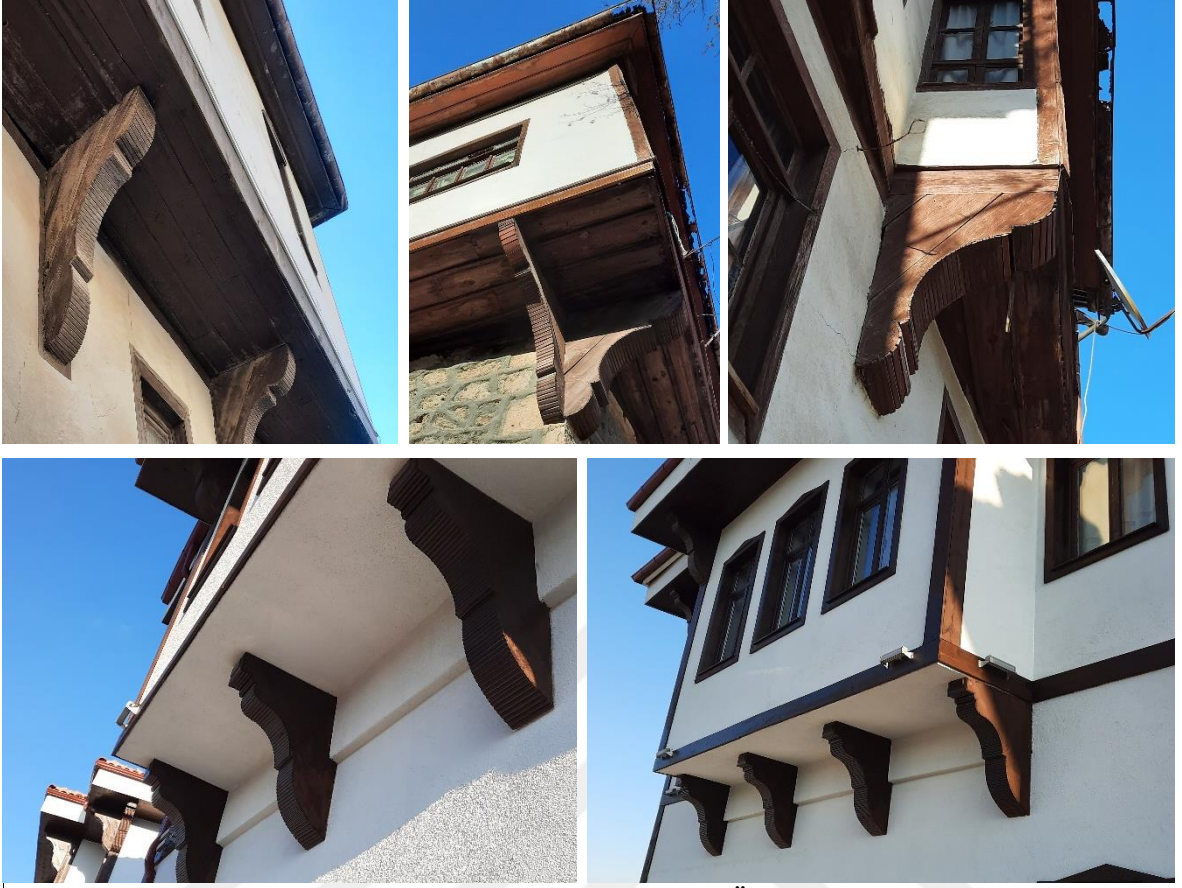
Şekil 34. Ahşap payandalar ve destekledikleri çıkmalar (Özgün, 2022)
