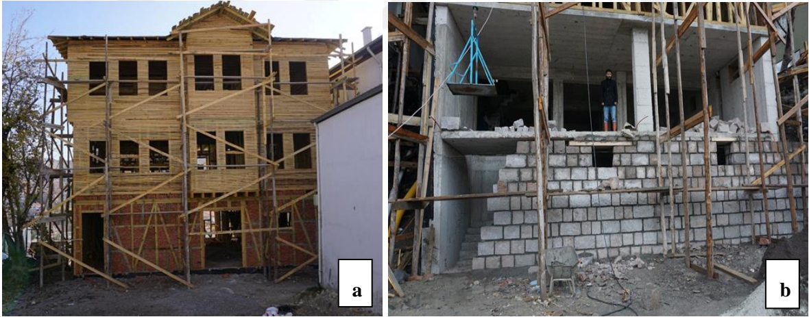
Şekil 64. Ömer Ağa Konağı yapım aşaması (Beypazarı Belediyesi a,b)
