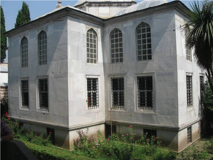
Resim 7. Kütüphanenin arka cephesi
