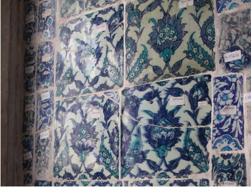
Resim 18. Pencere iç duvarlarındaki çiniler
