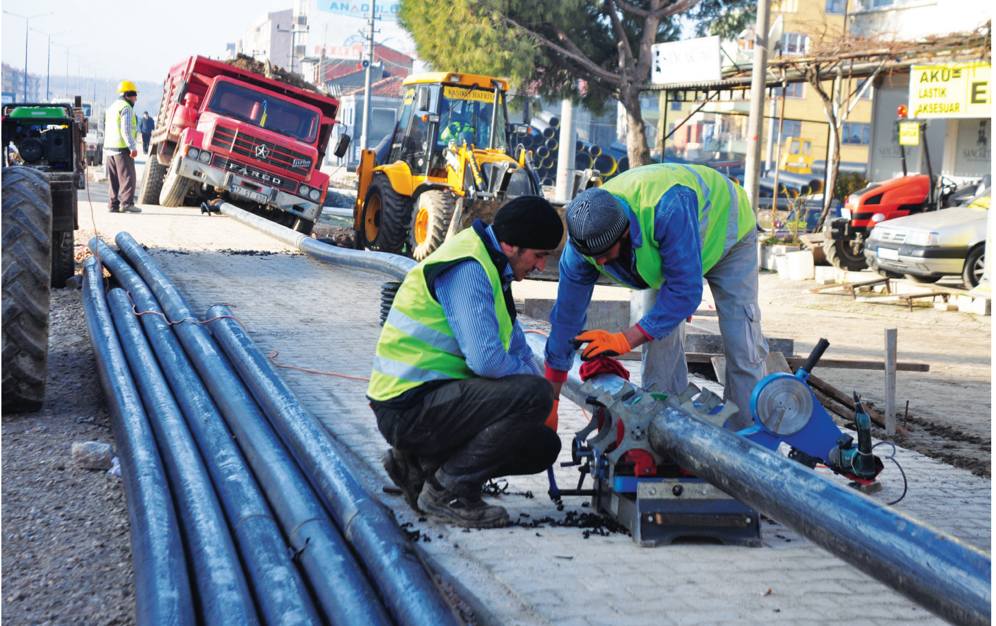
Şekil 2. Şebeke borusu döşeme çalışmaları.
