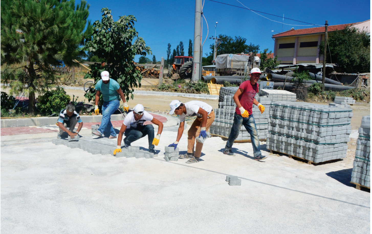
Şekil 6. Kilit parke taş döşeme çalışmaları.
