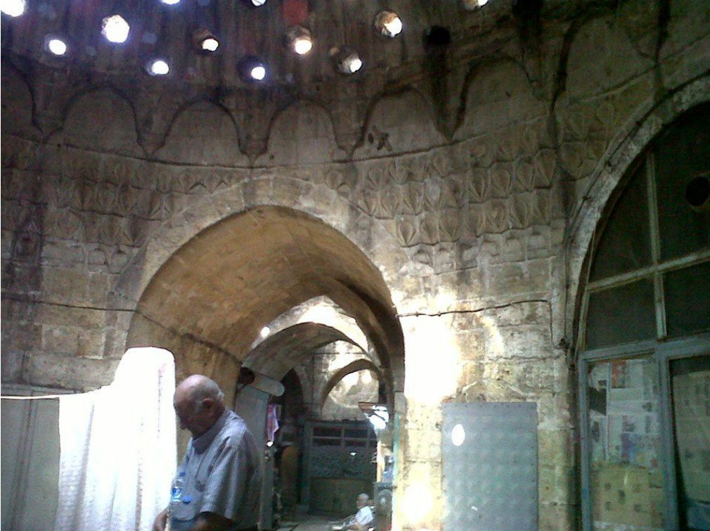
Fotoğraf 2.218: Gaziantep Hüseyin Paşa Hamamı sıcaklık mekanı kubbeye geçiş öğeleri
