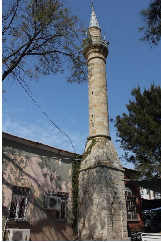
Fotoğraf 2.433: İzmir Çandarlı Merkez Cami doğu cephe
