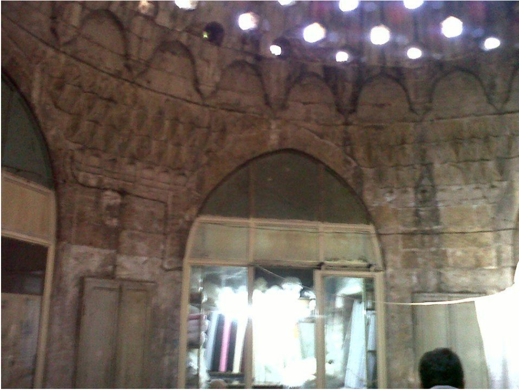
Fotoğraf 2.220: Gaziantep Hüseyin Paşa Hamamı sıcaklık mekanına açılan eyvan ve halvetler
