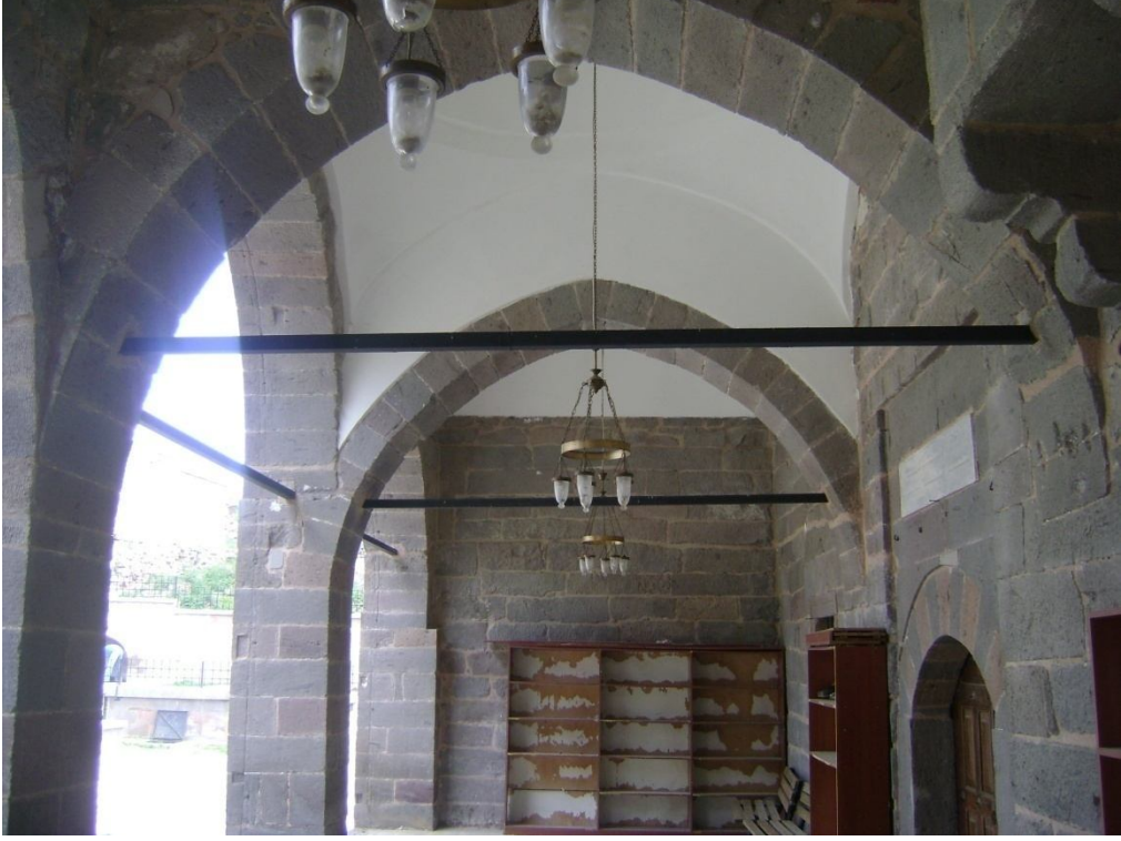
Fotoğraf 2.567: Kayseri Erkilet Nişancı Mehmet Paşa Cami son cemaat yeri revağı örtü sistemi
