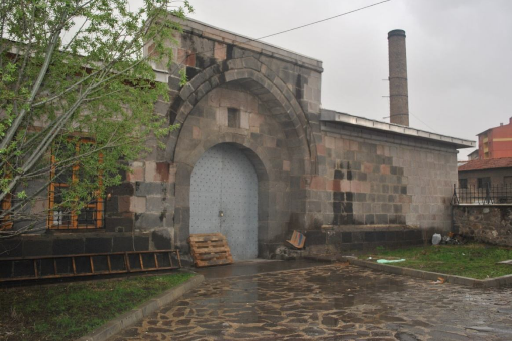
Fotoğraf 2.169: Erzurum Gümrük (Hacı Derviş) Külliyesi hanı giriş cephesi (batı)
