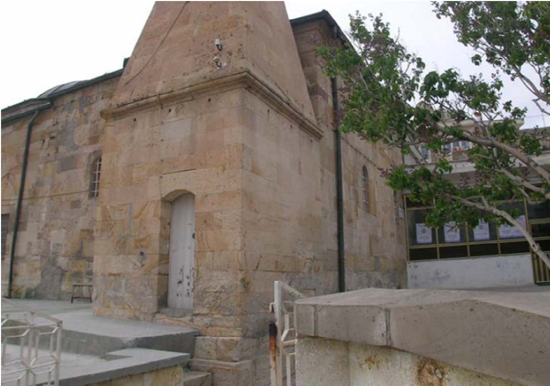
Fotoğraf 2.710: Nevşehir Nar Kasabası Eski Cami doğu cephe
