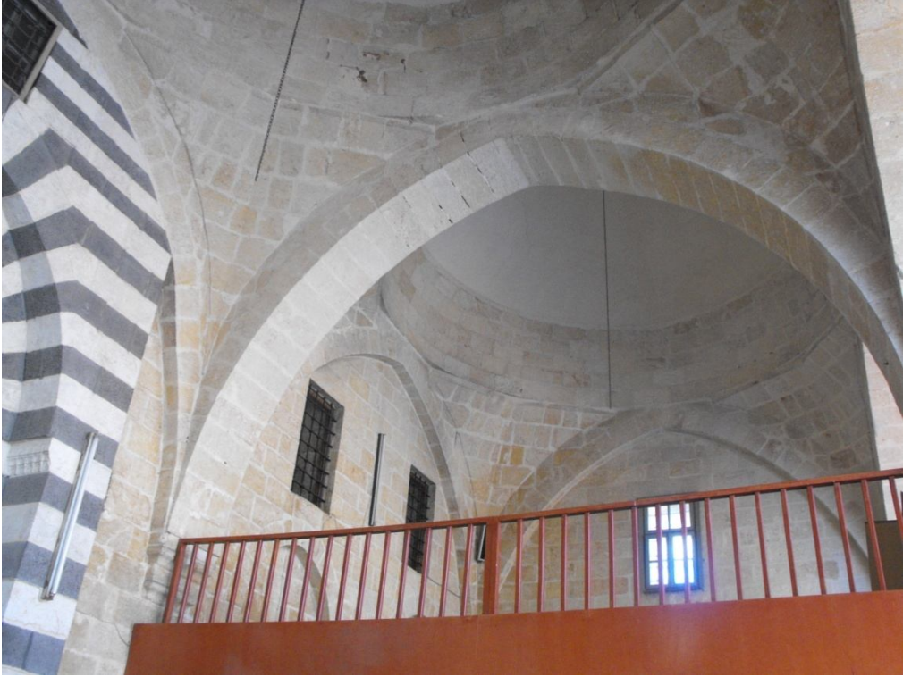
Fotoğraf 2.184: Gaziantep Hüseyin Paşa Cami son cemaat yeri revağı örtü sistemi
