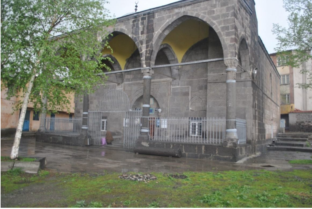
Fotoğraf 2.139: Erzurum Gümrük (Hacı Derviş) Külliyesi Cami kuzey cephe
