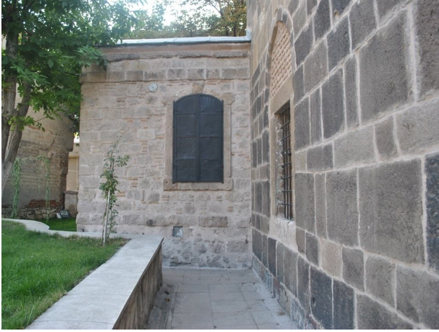
Fotoğraf 2.97: Afyon Yeni Cami Külliyesi kütüphane doğu cephe
