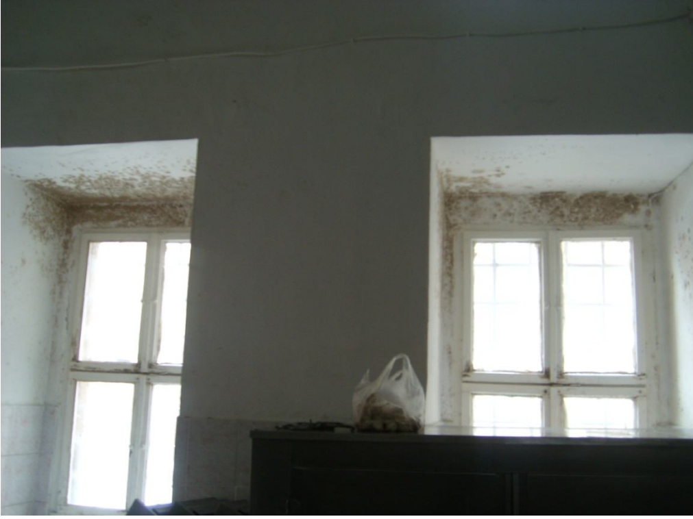
Fotoğraf 2.329: Nevşehir Damat İbrahim Paşa İmareti mutfak bölümü güney duvardaki pencereler
