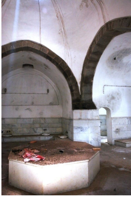
Fotoğraf 2.165: Erzurum Gümrük (Hacı Derviş) Külliyesi hamam sıcaklık mekanı (Vakıflar Genel Müdürlüğü arşivi 250001033-FT004-2009'nolu dosya)
