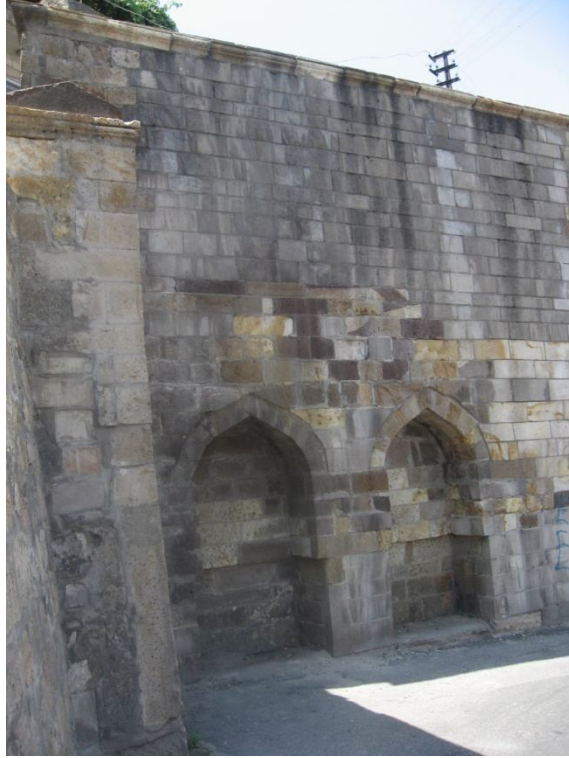
Fotoğraf 2.340: Nevşehir Damat İbrahim Paşa Sıbyan Mektebi doğu cephedeki nişler
