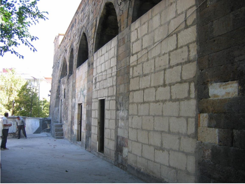
Fotoğraf 2.359: Nevşehir Damat İbrahim Paşa Hanı kuzeydoğu cephe
