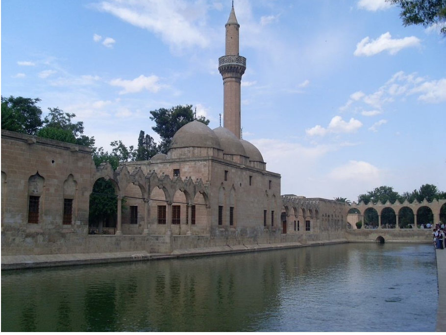
Fotoğraf 2.107: Şanlıurfa Rızvaniye Cami güney cephe (batıdan bakış)
