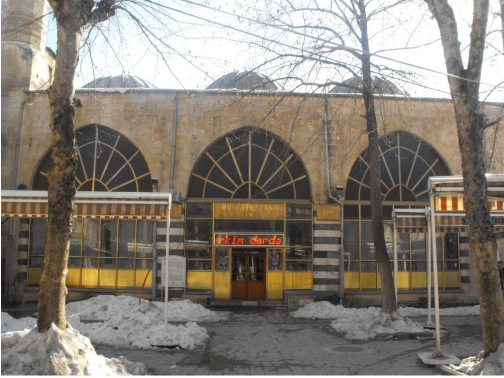
Fotoğraf 2.183: Gaziantep Hüseyin Paşa Cami kuzey cephe
