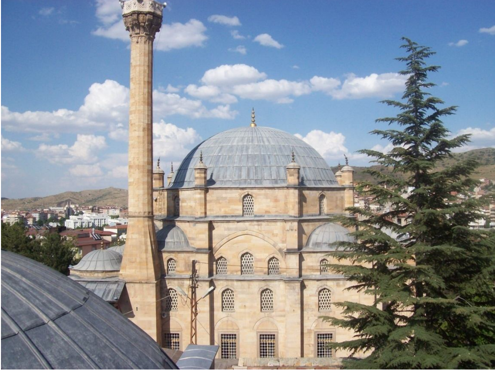
Fotoğraf 2.233: Nevşehir Damat İbrahim Paşa Cami batı cephe
