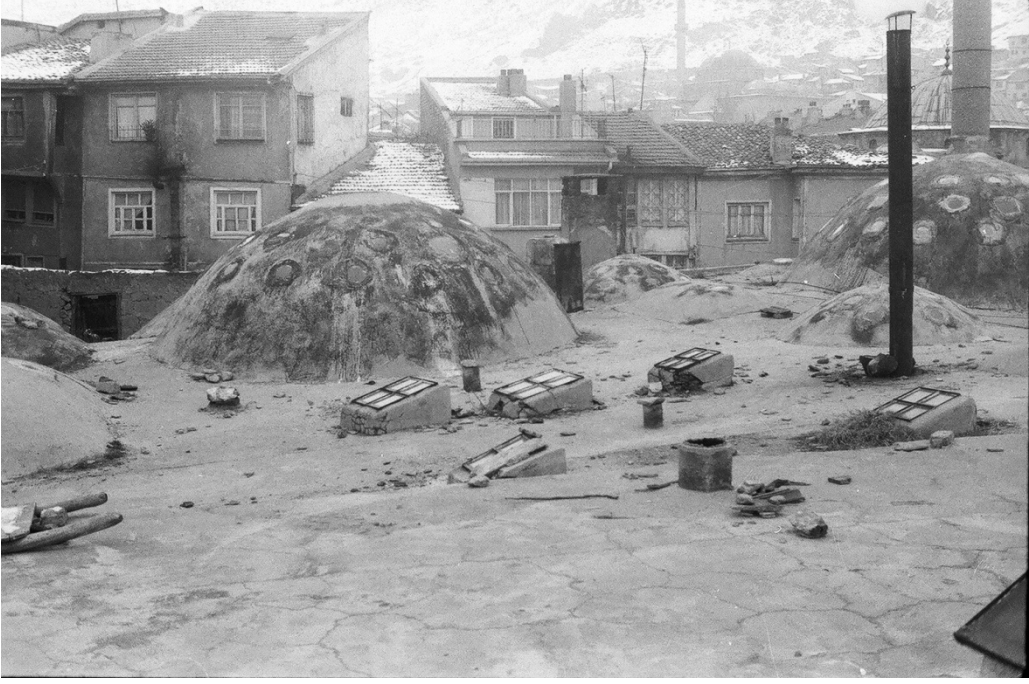
Fotoğraf 2.101: Afyon Yeni Cami Külliyesi hamam örtü sistemi (Vakıflar Genel Müdürlüğü Arşivi 030001088-FT002-1980 nolu dosya)
