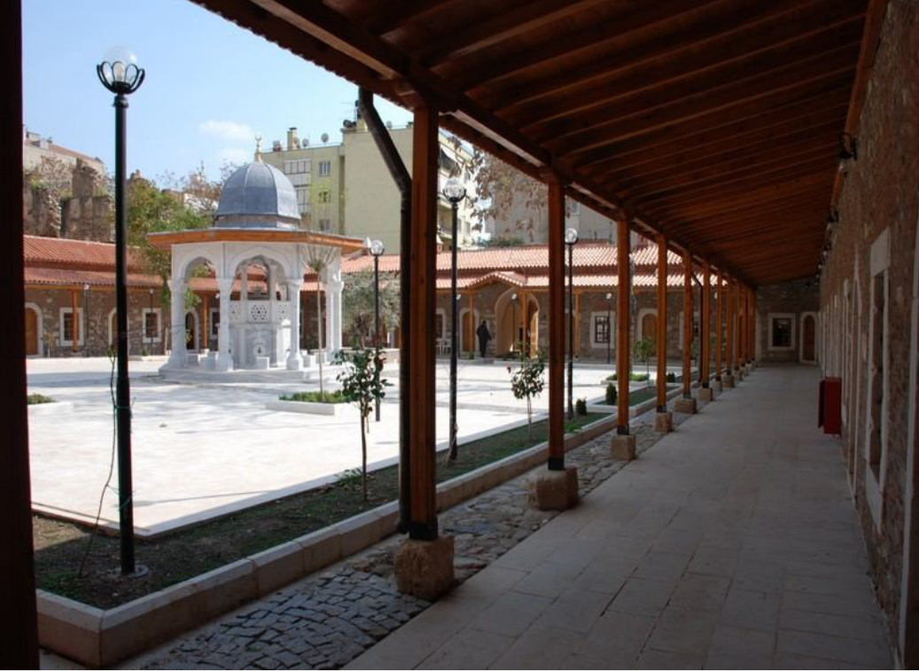
Fotoğraf 2.19: Aydın Nasuh Paşa Medresesi genel görünüş
