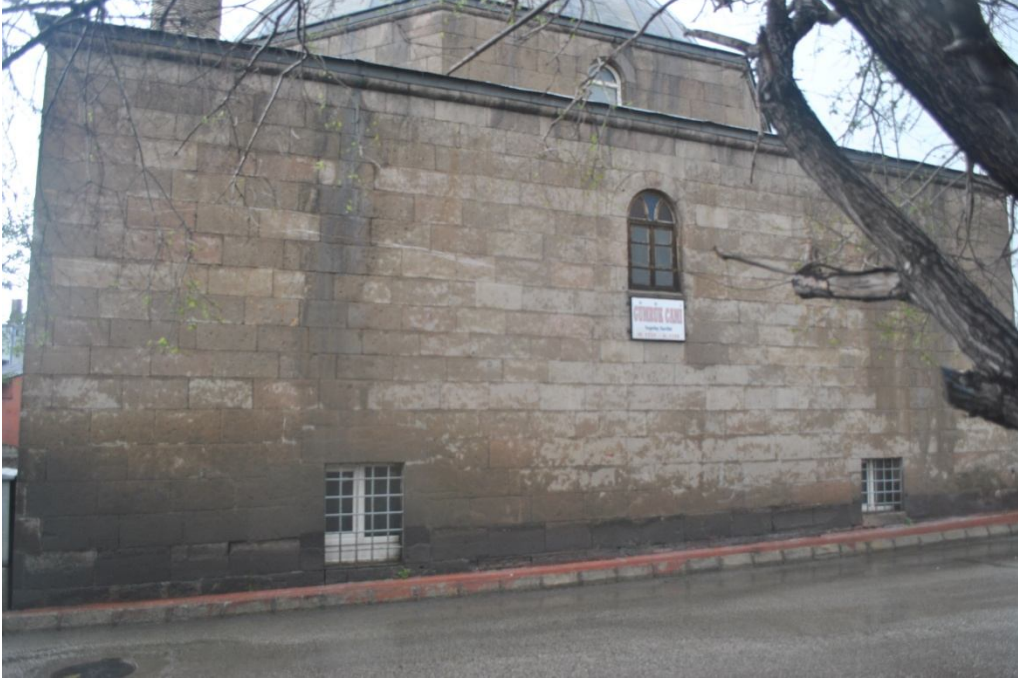
Fotoğraf 2.141: Erzurum Gümrük (Hacı Derviş) Külliyesi Cami güney cephe
