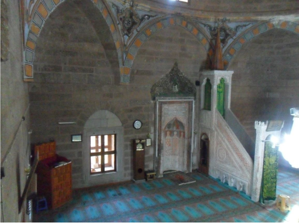
Fotoğraf 2.449: Kayseri Molu Köyü Cami iç mekan güney cephe
