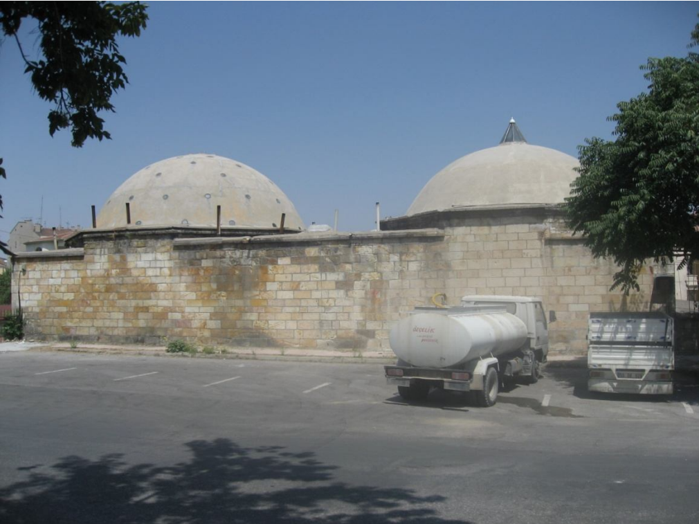
Fotoğraf 2.344: Nevşehir Damat İbrahim Paşa Hamamı güneybatı cephe
