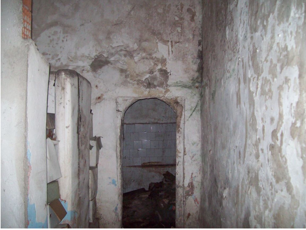
Fotoğraf 2.35: Aydın Nasuh Paşa Hamamı tuvalet
