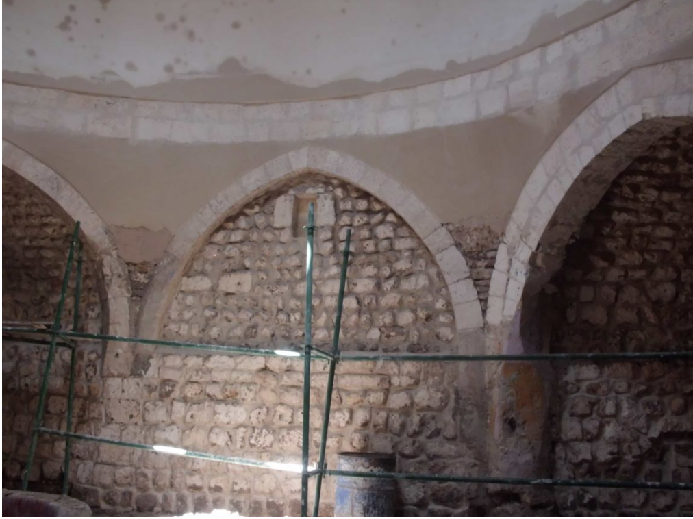
Fotoğraf 2.789: Şanlıurfa Vezir Hamamı soğukluk mekanı kubbeye geçiş elemanları (restorasyon esnası)
