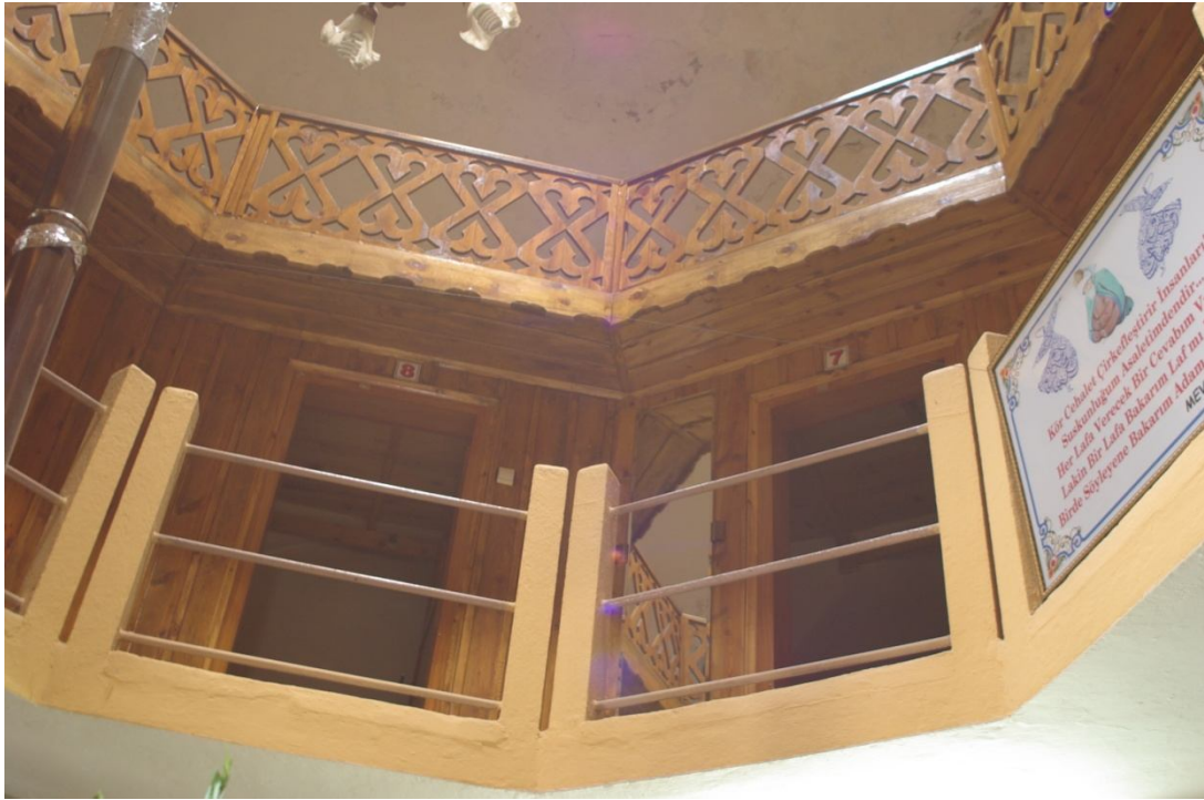
Fotoğraf 2.348: Nevşehir Damat İbrahim Paşa Hamamı soğukluk mekanı ahşap galeri
