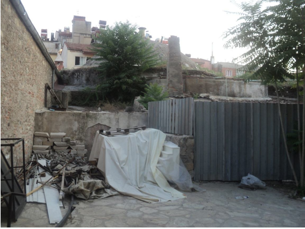
Fotoğraf 2.53: Aydın Nasuh Paşa Hamamı dış cephe (kuzey)
