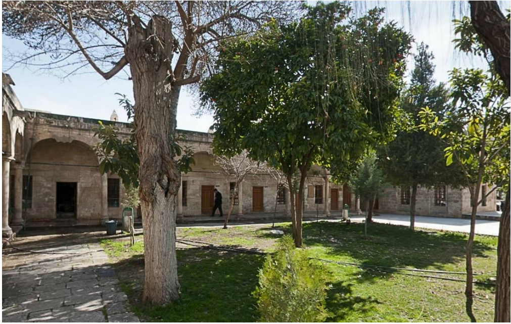
Fotoğraf 2.130: Şanlıurfa Rızvaniye Medresesi doğu cephe
