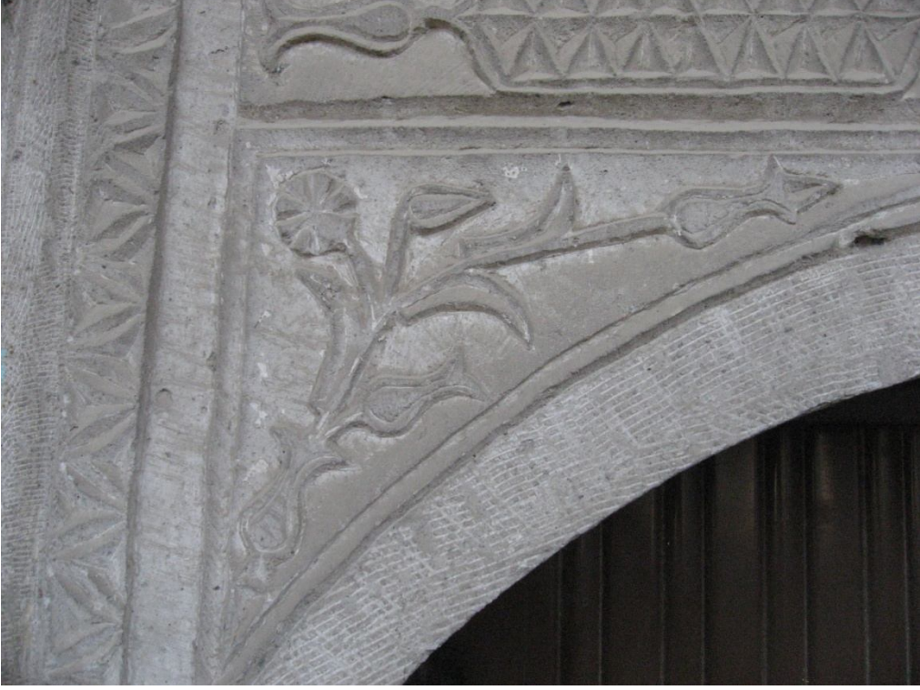
Fotoğraf 2.481: Kayseri Hasinli Cami harim giriş kapısı esas giriş açıklığı kemer köşesi vazodan çıkan lale ve karnifiller
