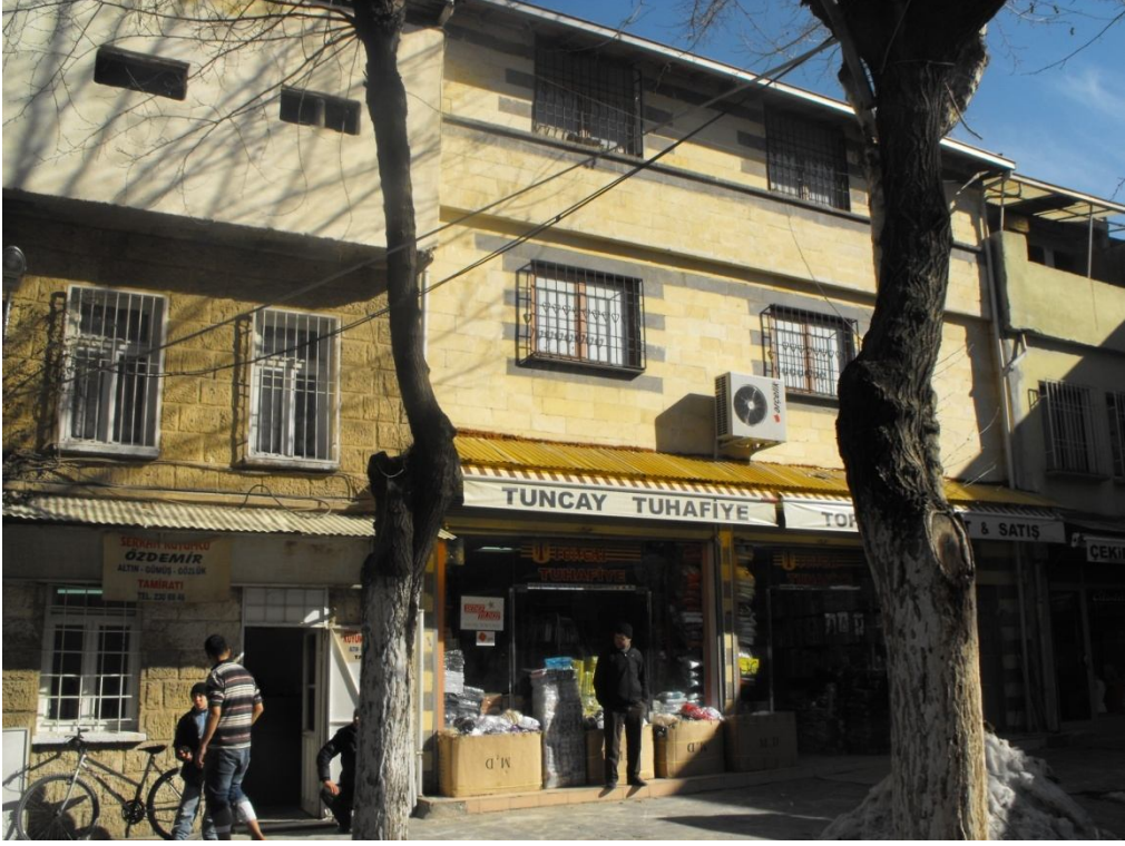
Fotoğraf 2.181: Gaziantep Hüseyin Paşa Cami avlusu doğu cephe
