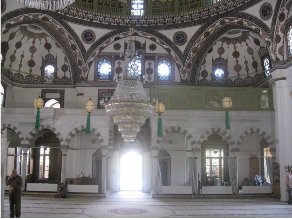
Fotoğraf 2.259: Nevşehir Damat İbrahim Paşa Camii iç mekan kuzey cephe
