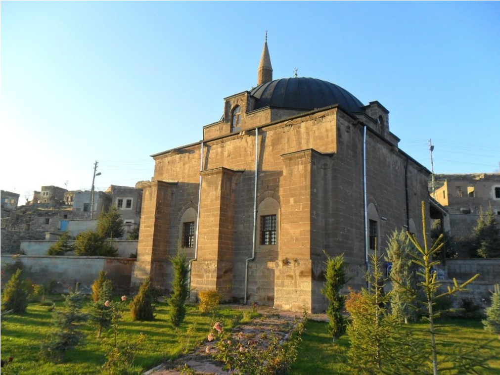
Fotoğraf 2.444: Kayseri Molu Köyü Cami güney cephe
