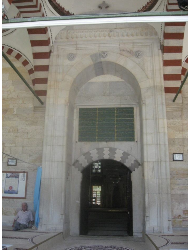
Fotoğraf 2.253: Nevşehir Damat İbrahim Paşa Cami harim giriş kapısı
