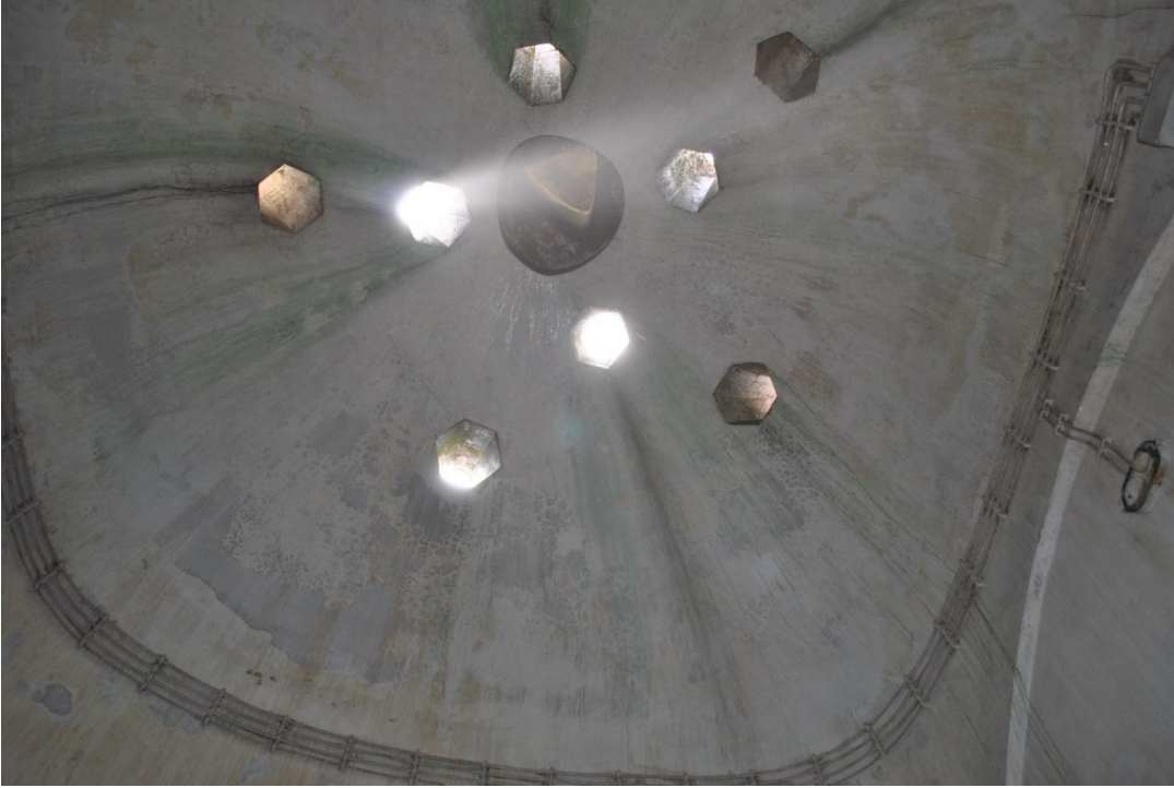
Fotoğraf 2.785: Erzurum Saray Hamamı ılıklik mekanını örten kubbelerdeki altıgen fil gözleri
