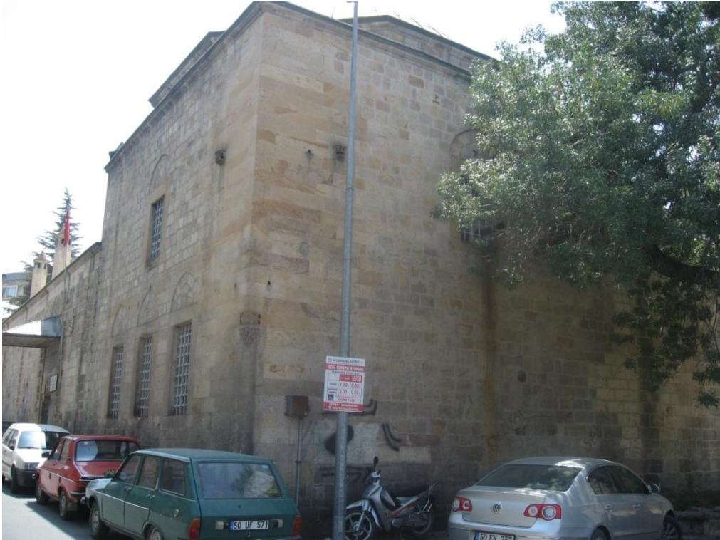
Fotoğraf 2.286: Nevşehir Damat İbrahim Paşa Medresesi kuzey cephe
