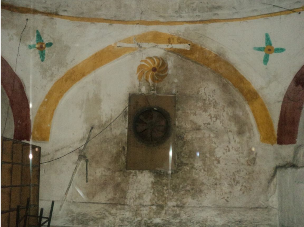
Fotoğraf 2.42: Aydın Nasuh Paşa Hamamı sıcaklık kubbeğe geçiş ögesi
