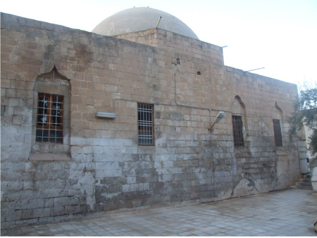
Fotoğraf 2.643: Şanlıurfa Hacı Lütfullah Cami güney cephe
