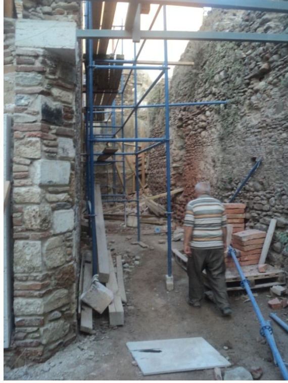
Fotoğraf 2.67: Aydın Nasuh Paşa Hanı küçük avluya geçişi sağlayan koridor
