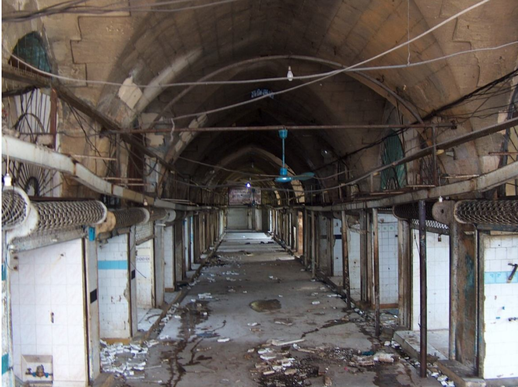
Fotoğraf 2.230: Gaziantep Hüseyin Paşa Arastası (Zincirli Bedesten) uzun kenar iç kısım batıdan bakış restorasyon öncesi (Vakıflar Genel Müdürlüğü Arşivi 270101237-FT001 nolu dosya)
