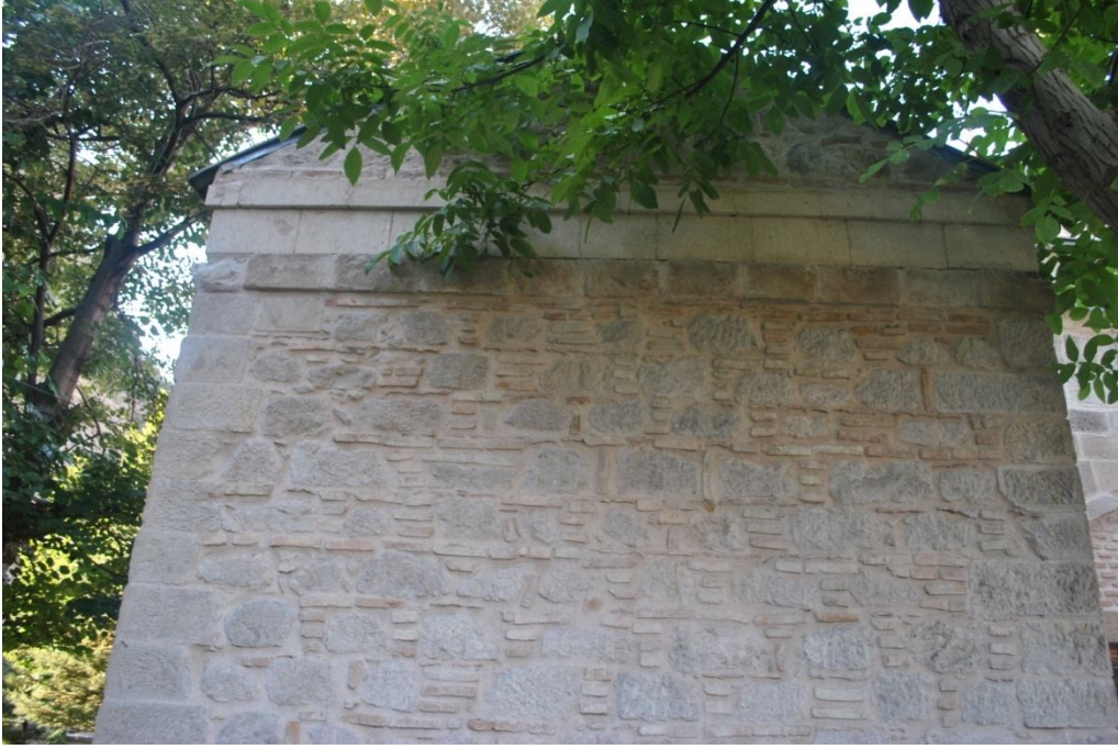
Fotoğraf 2.99: Afyon Yeni Cami Külliyesi kütüphane güney cephe
