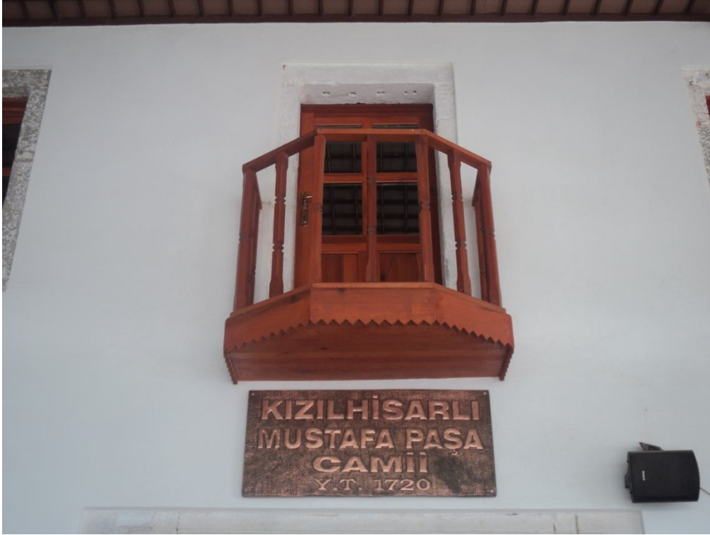
Fotoğraf 2.657: Bodrum Kızılhisarlı Mustafa Paşa Cami batı cephe
