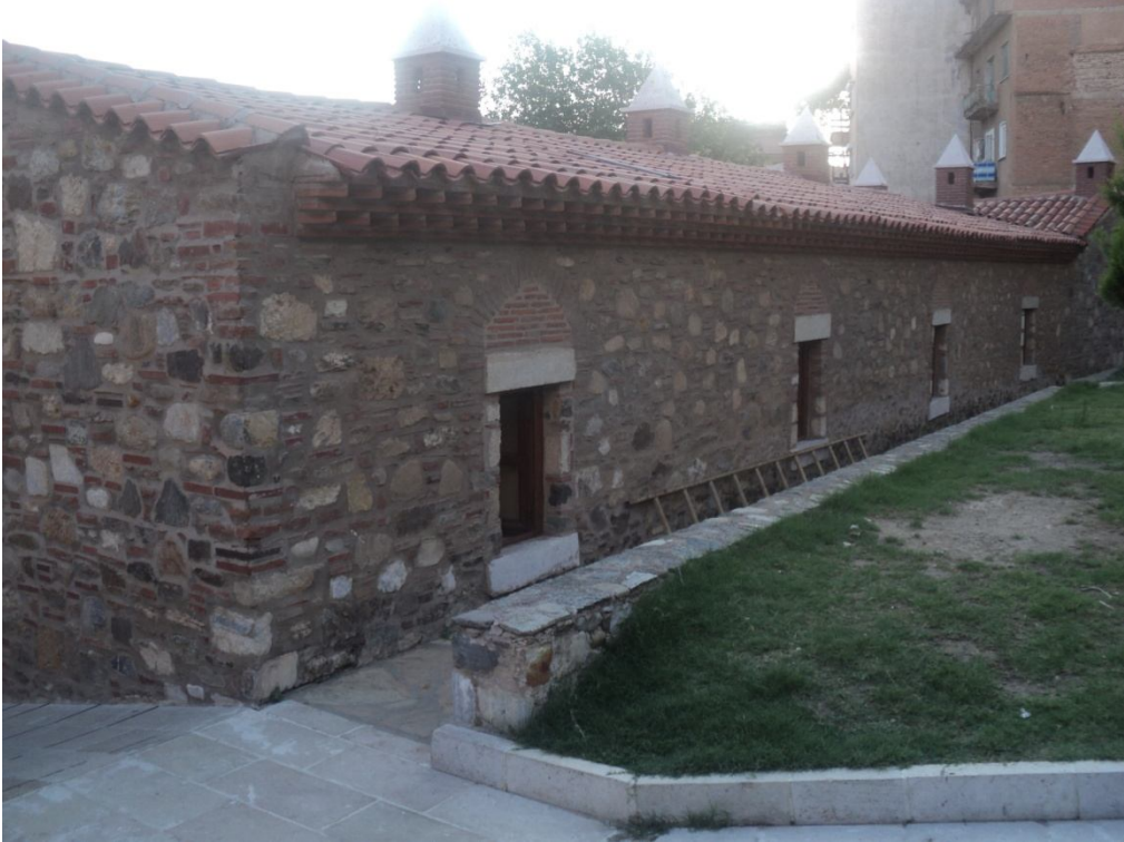
Fotoğraf 2.30: Aydın Nasuh Paşa Medresesi dış cephe (kuzey)
