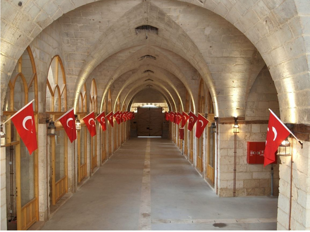
Fotoğraf 2.231: Gaziantep Hüseyin Paşa Arastası (Zincirli Bedesten) kısa kenar iç kısım kuzeyden bakış (restorasyon sonrası)
