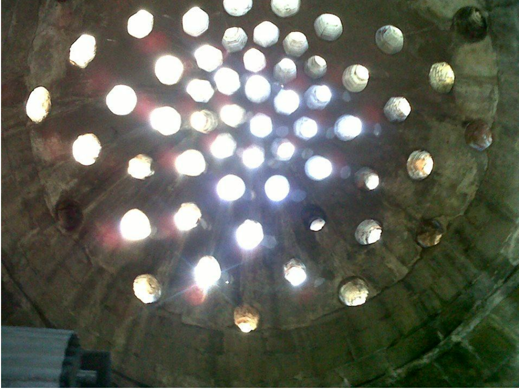
Fotoğraf 2.219: Gaziantep Hüseyin Paşa Hamamı sıcaklık mekanı kubbe
