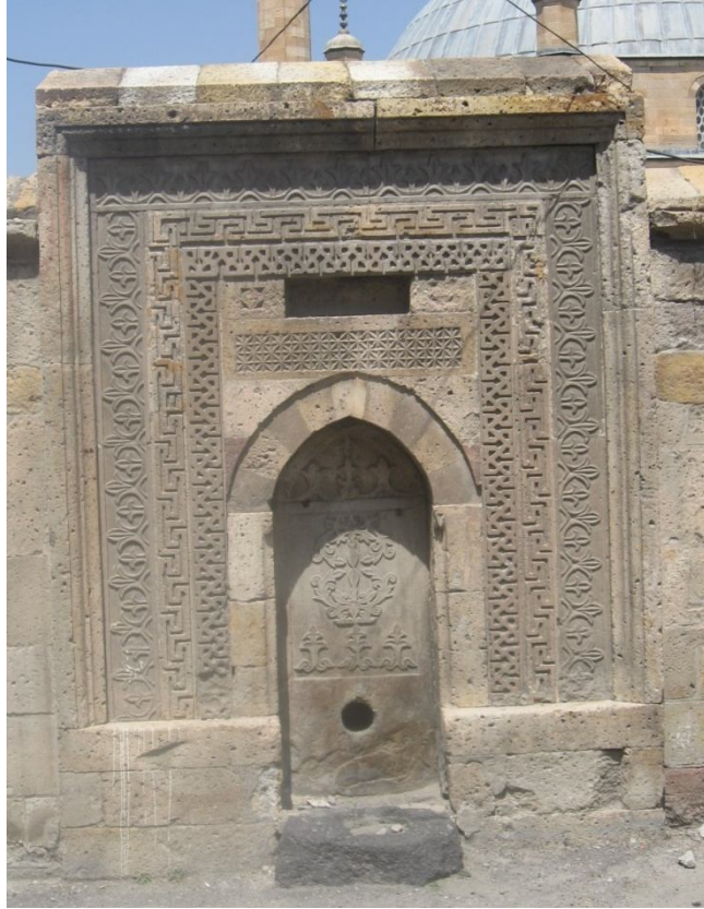
Fotoğraf 2.366: Nevşehir Damat İbrahim Paşa cami avlusu güney duvarındaki çeşme
