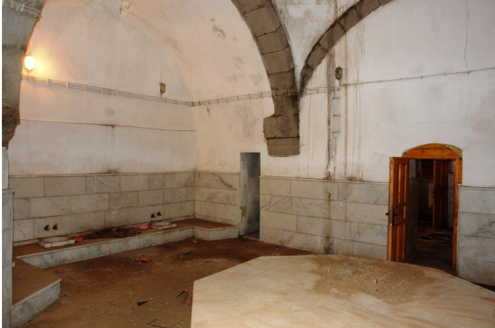
Fotoğraf 2.164: Erzurum Gümrük (Hacı Derviş) Külliyesi hamam sıcaklık mekanı (Vakıflar Genel Müdürlüğü arşivi 250001033-FT004-2009'nolu dosya)
