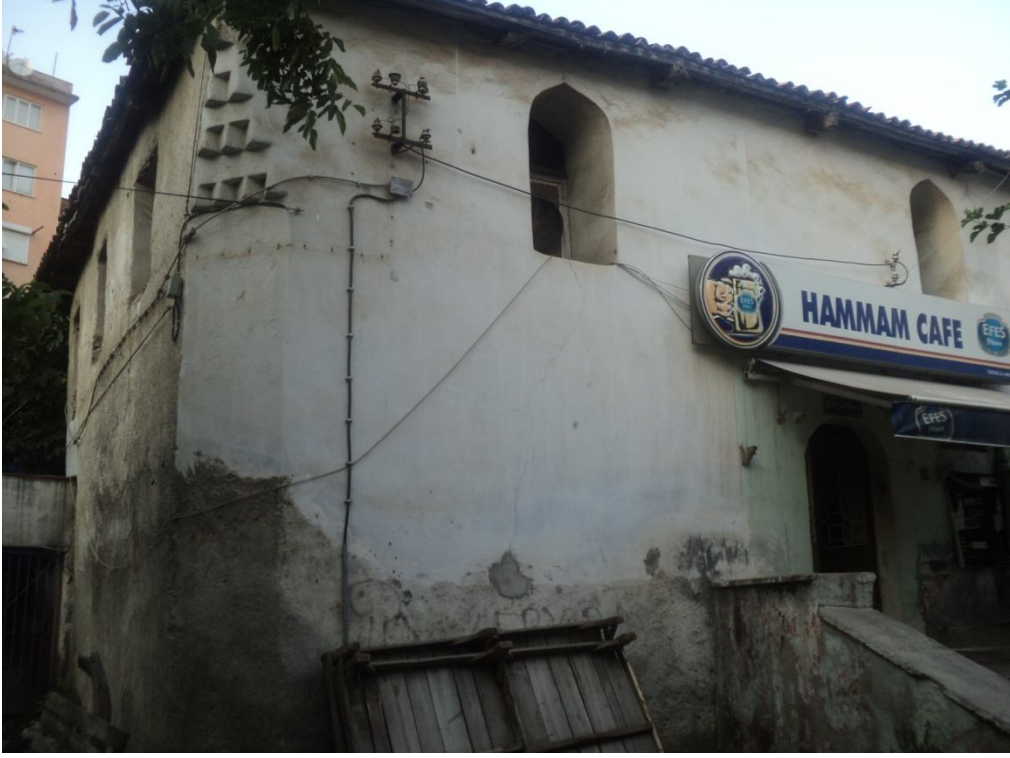
Fotoğraf 2.33: Aydın Nasuh Paşa Hamamı giriş ünitesi
