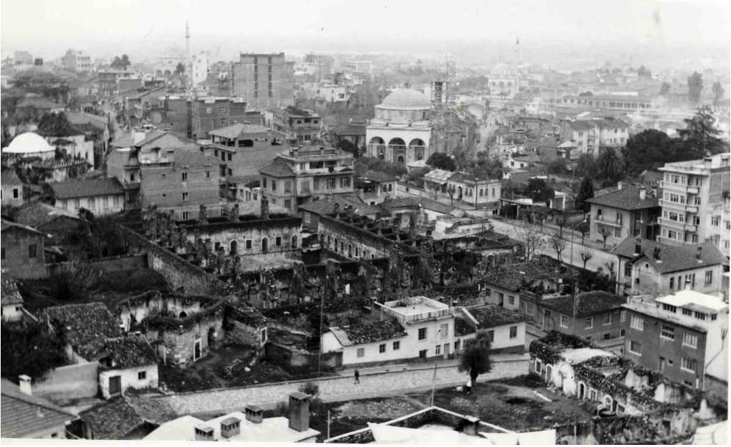
Fotoğraf 2.14: Aydın Nasuh Paşa Medresesi restorasyon öncesi durumu (Vakıflar Genel Müdürlüğü Arşivi 090001017-FT003 nolu dosya)
