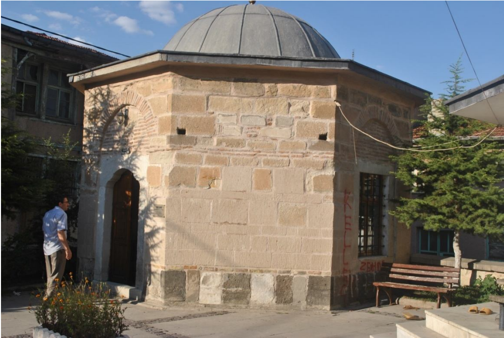
Fotoğraf 2.92: Afyon Yeni Cami Külliyesi muvakkithane
