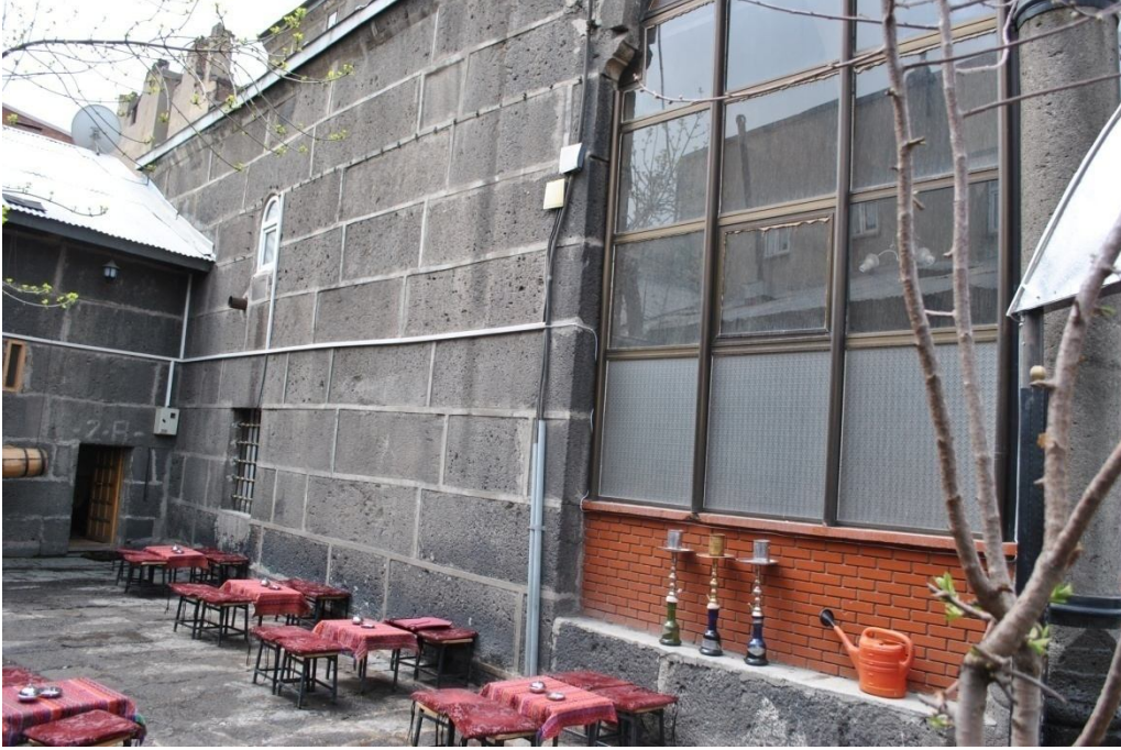
Fotoğraf 2.526: Erzurum Pervizoğlu Cami doğu cephe
