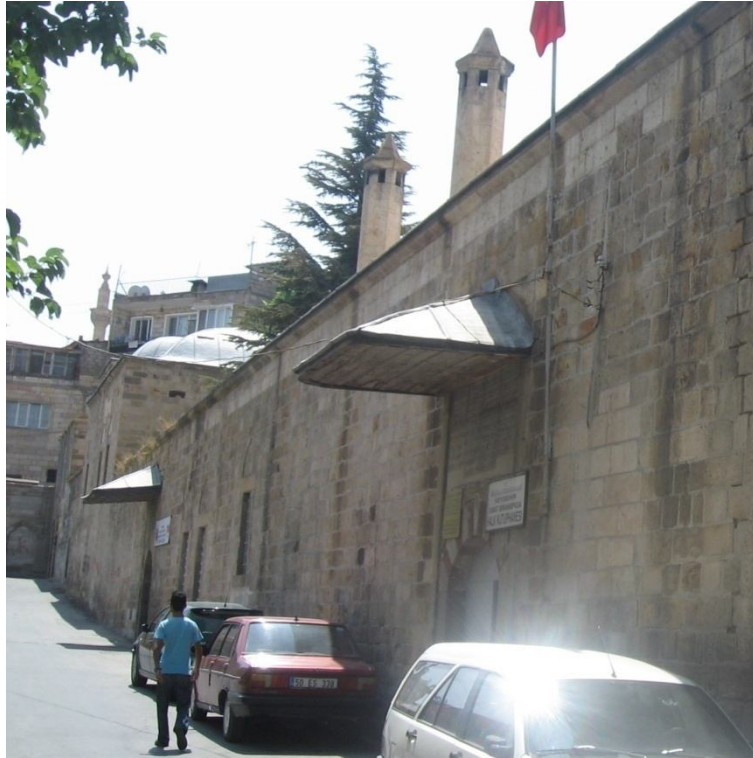
Fotoğraf 2.320: Nevşehir Damat İbrahim Paşa İmareti giriş cephesi
