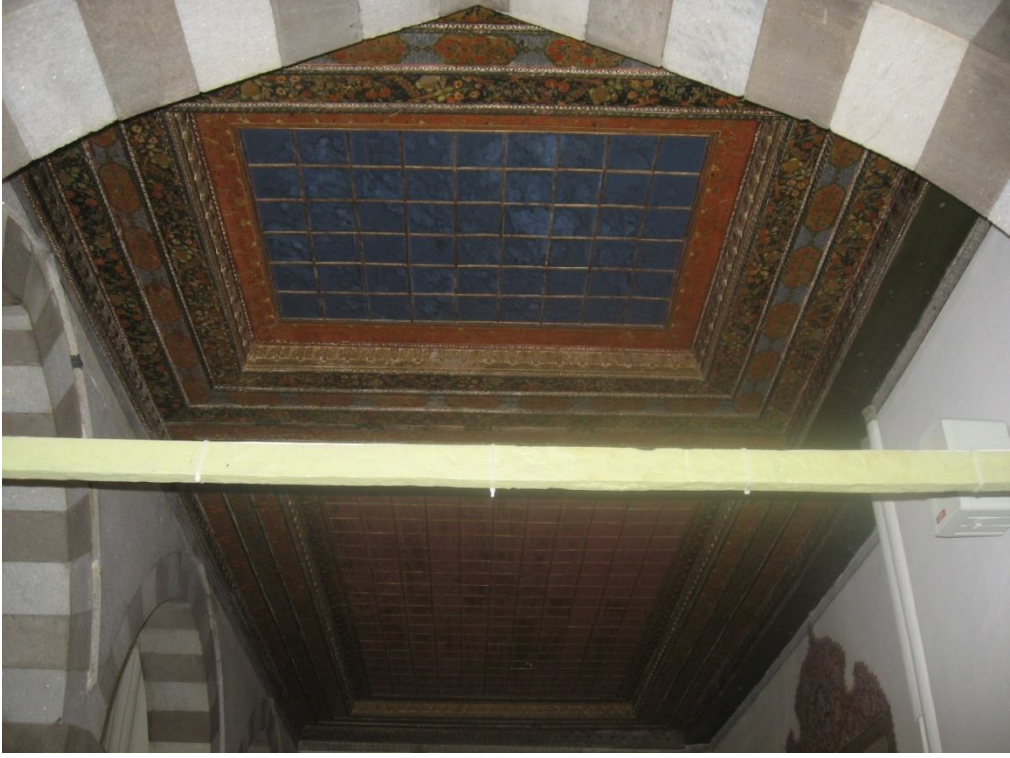
Fotoğraf 2.273: Nevşehir Damat İbrahim Paşa Cami kadınlar mahfili altındaki ahşap tavan
