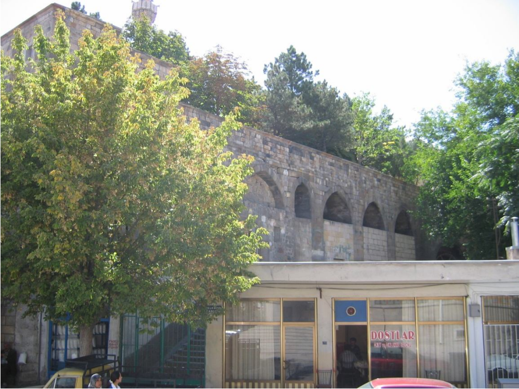
Fotoğraf 2.358: Nevşehir Damat İbrahim Paşa Hanı kuzeydoğu cephe
