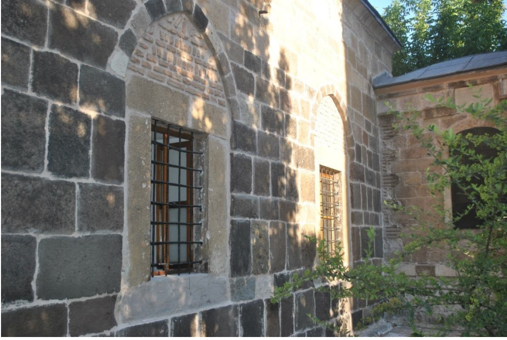
Fotoğraf 2.75: Afyon Yeni Cami batı cephe
