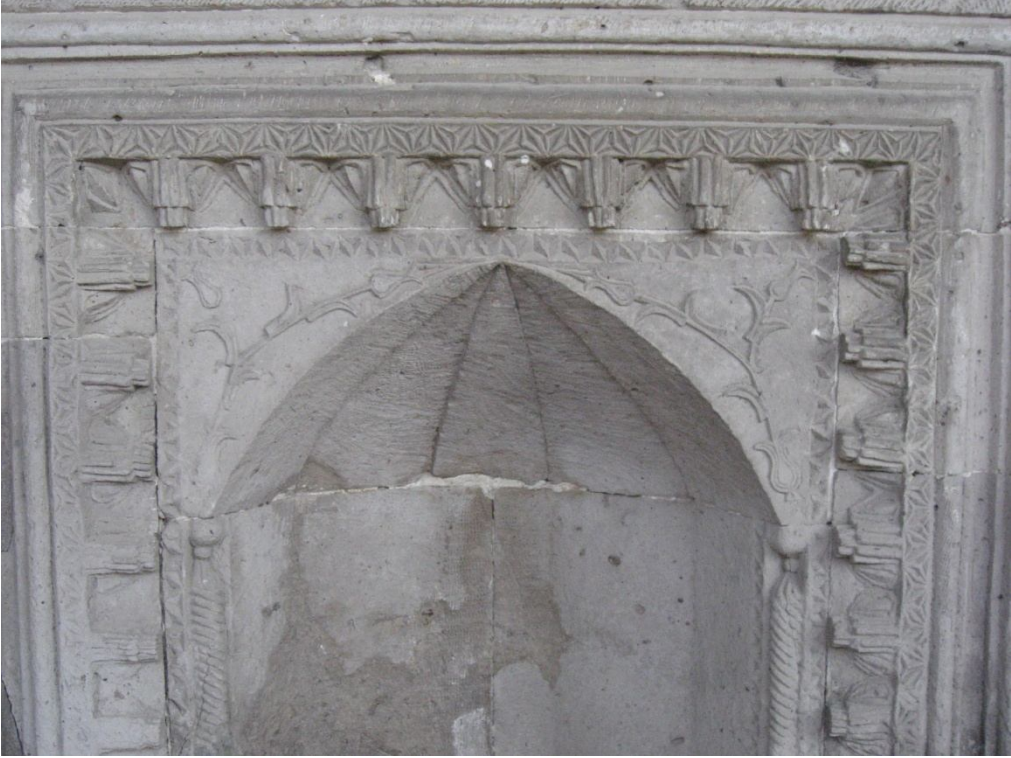
Fotoğraf 2.476: Kayseri Hasinli Cami kuzey cephede kapının batısındaki mihrabiye nişi süsleme detayı
