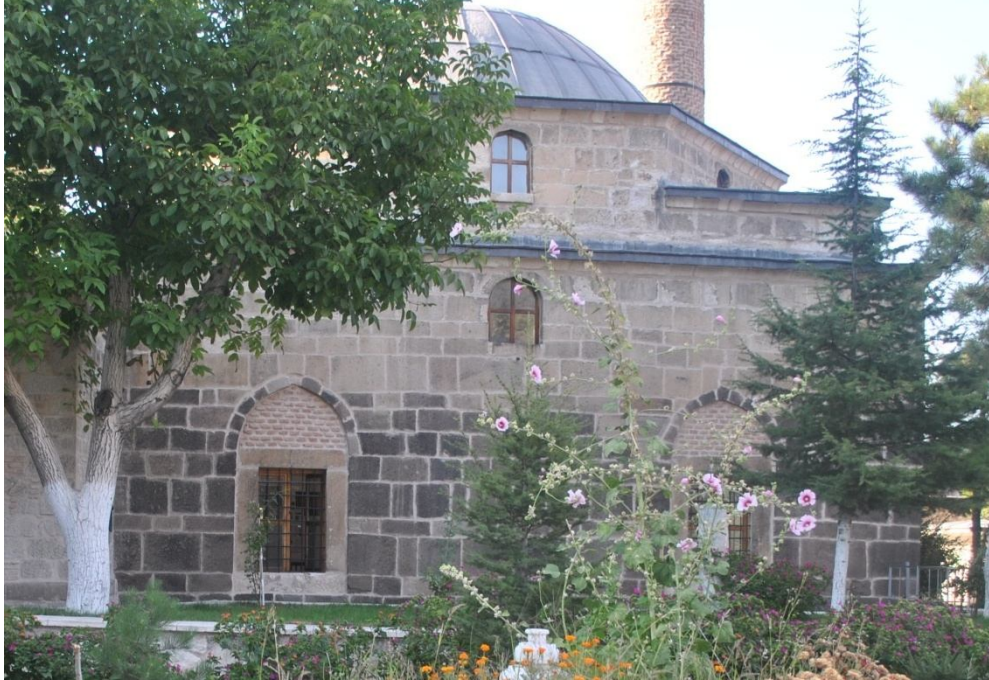
Fotoğraf 2.74: Afyon Yeni Cami güney cephe
