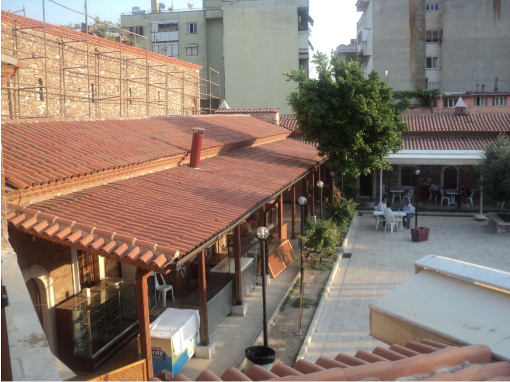
Fotoğraf 2.22: Aydın Nasuh Paşa Medresesi doğu cephe
