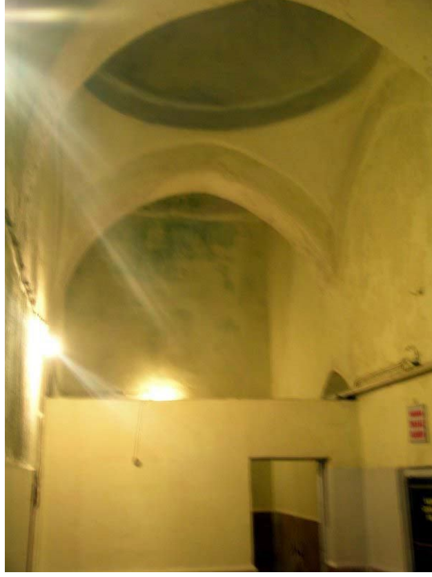
Fotoğraf 2.351: Nevşehir Damat İbrahim Paşa Hamamı ılıklik mekanı örtü sistemi
