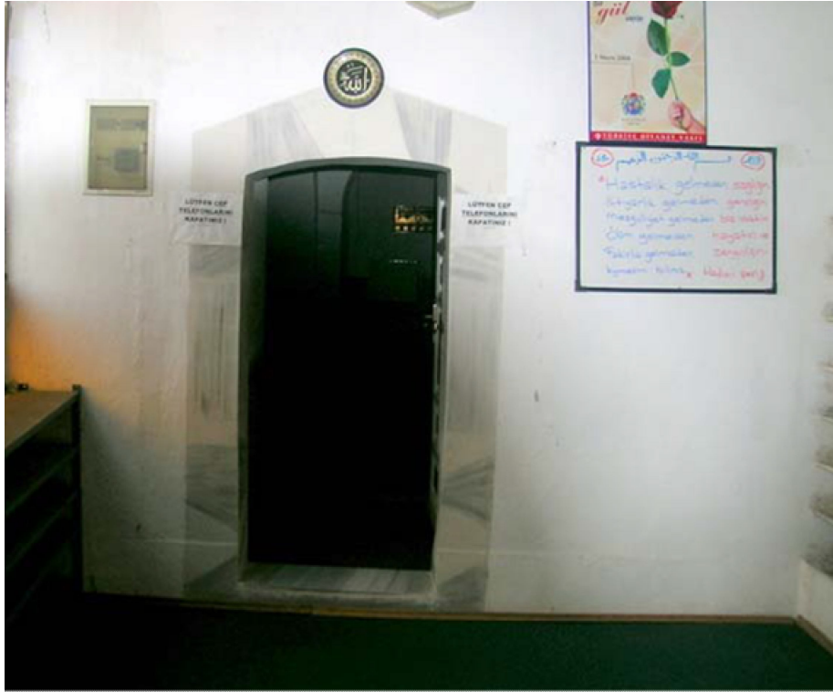
Fotoğraf 2.711: Nevşehir Nar Kasabası Eski Cami harim giriş kapısı
