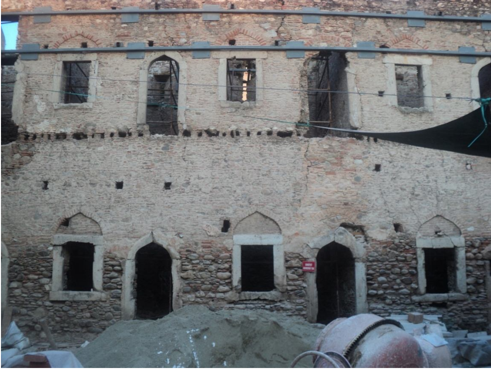
Fotoğraf 2.66: Aydın Nasuh Paşa Hanı pencere ve kapılar
