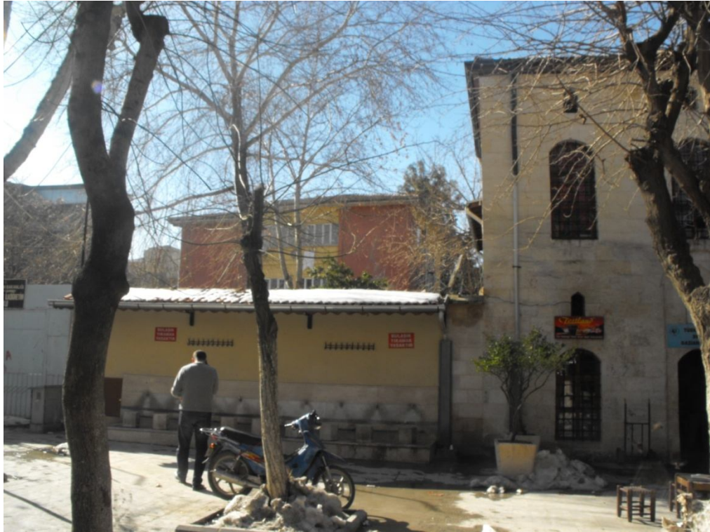
Fotoğraf 2.180: Gaziantep Hüseyin Paşa Cami avlusu batı cephe
