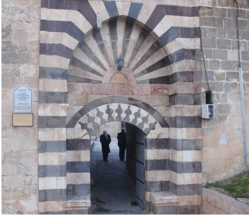
Fotoğraf 2.103: Şanlıurfa Rızvaniye Külliyesi giriş kapısı
