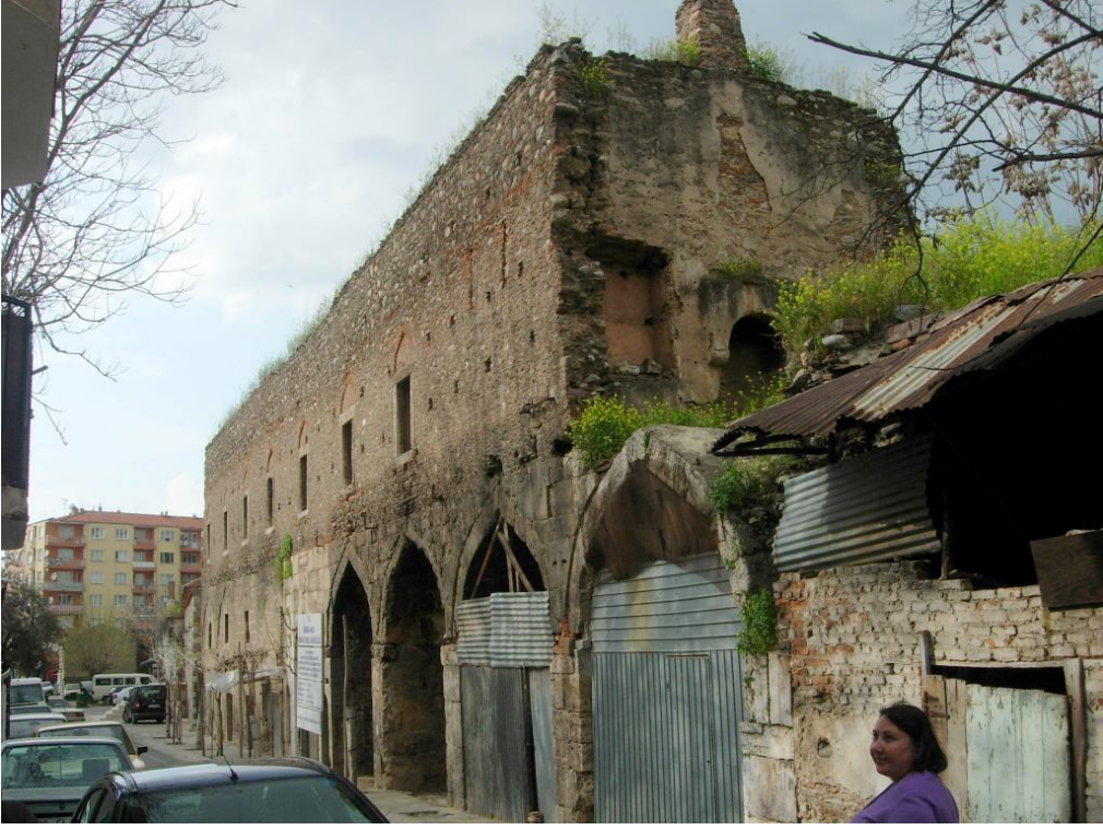
Fotoğraf 2.55: Aydın Nasuh Paşa Hanı güney cephe (doğudan bakış)
