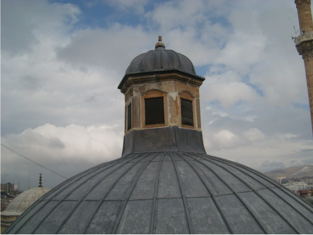
Fotoğraf 2.330: Nevşehir Damat İbrahim Paşa İmareti mutfak bölümü kubbe aydınlık feneri
