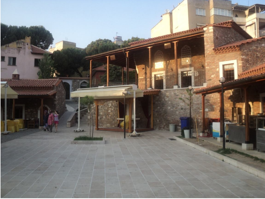
Fotoğraf 2.3: Aydın Nasuh Paşa Külliyesi derashane-mescid kuzey cephe ve hoca odası
