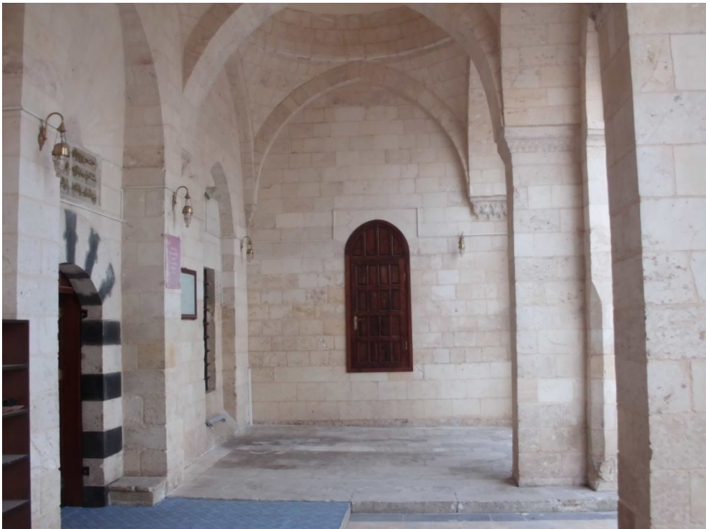
Fotoğraf 2.736: Şanlıurfa Hüseyin Paşa Cami son cemaat yeri revağı (batıdan bakış)
