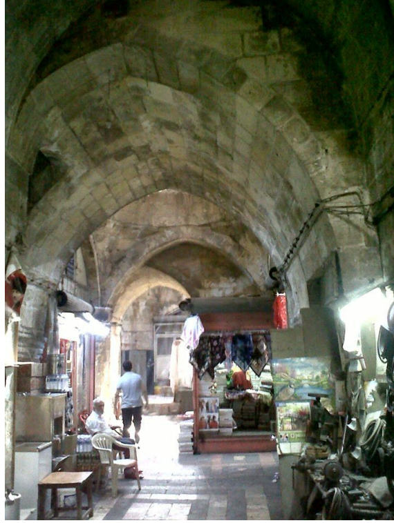
Fotoğraf 2.215: Gaziantep Hüseyin Paşa Hamamı ılıklık mekanı
