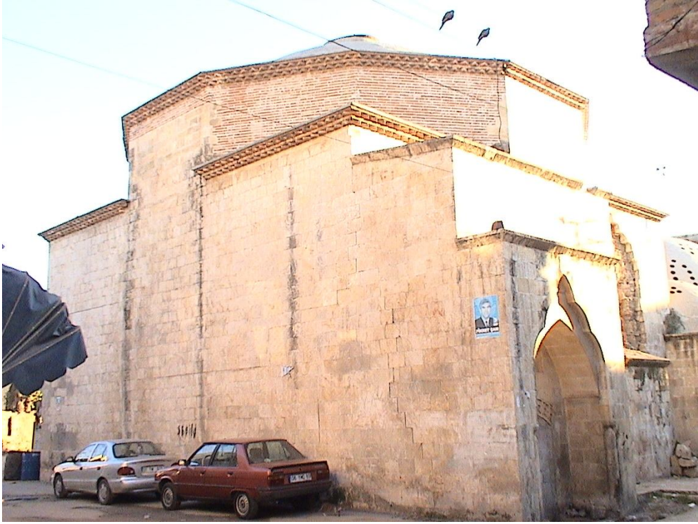
Fotoğraf 2.801: Adana Yeni Hamam soğukluk kuzey cephe
