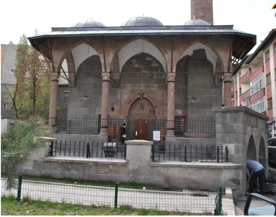
Fotoğraf 2.619: Erzurum Bakırcı Cami kuzey cephe
