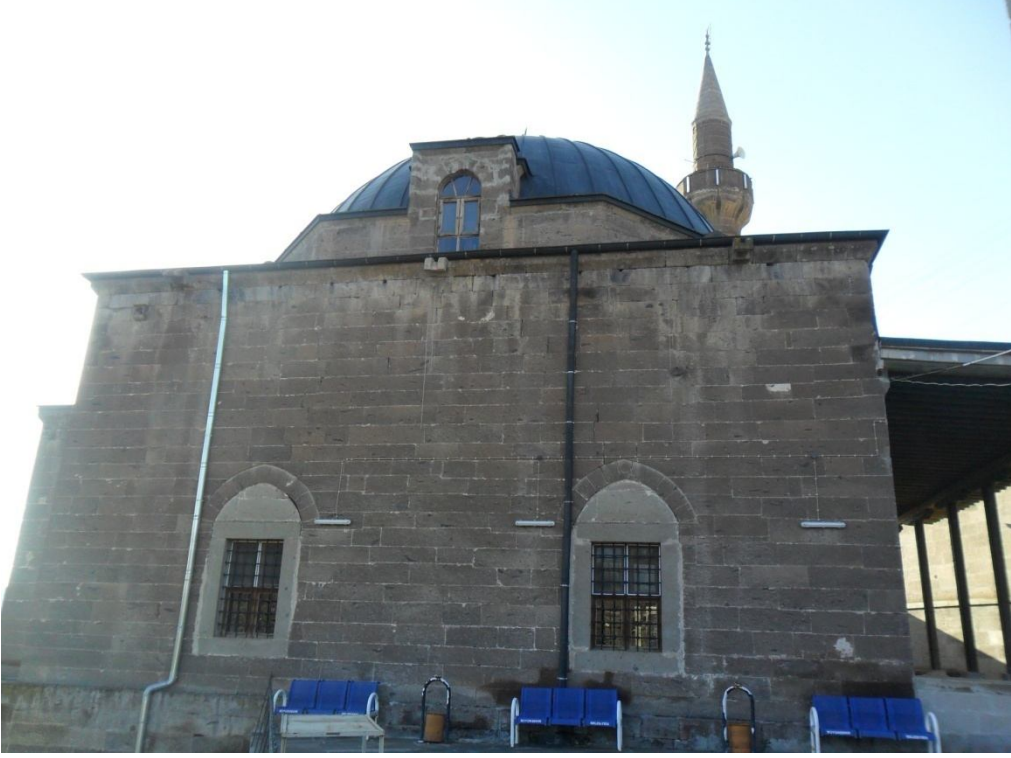
Fotoğraf 2.443: Kayseri Molu Köyü Cami doğu cephe
