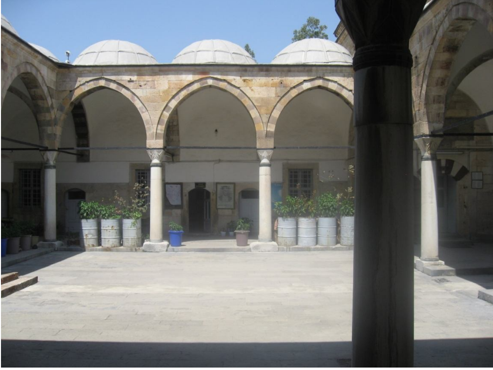
Fotoğraf 2.291: Nevşehir Damat İbrahim Paşa Medresesi kuzey kanadı
