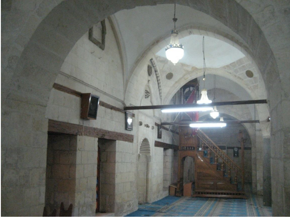
Fotoğraf 2.681: Adana Yeni Cami harim kuzey cephesi orijinal bölüm güney cephe
