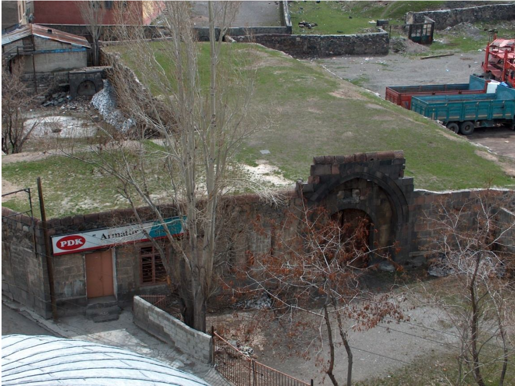
Fotoğraf 2.168: Erzurum Gümrük (Hacı Derviş) Külliyesi hanı genel görünüş restorasyon öncesi (Vakıflar Genel Müdürlüğü arşivi 250001073-FT008 nolu dosya)
