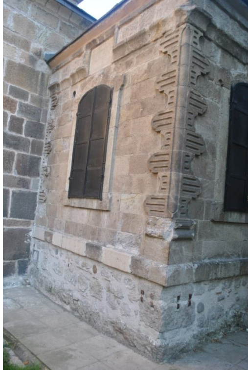
Fotoğraf 2.98: Afyon Yeni Cami Külliyesi kütüphane kuzey cephe
