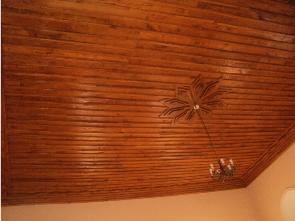
Fotoğraf 2.12: Aydın Nasuh Paşa Külliyesi dershane-mescid ahşap tavan
