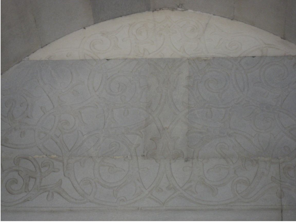
Fotoğraf 2.255: Nevşehir Damat İbrahim Paşa Cami harim giriş kapısı süsleme detayı
