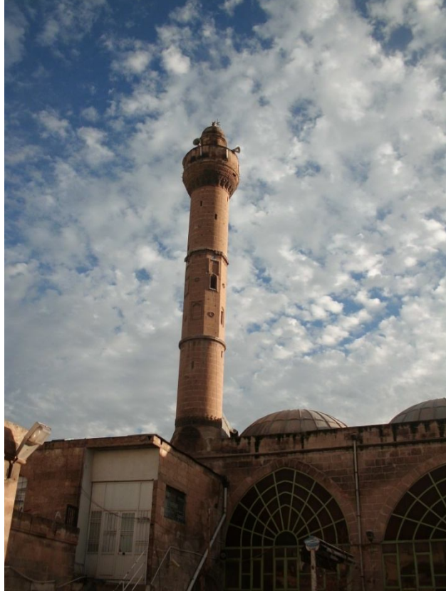
Fotoğraf 2.429: Şanhurfa Yusuf Paşa Cami minare
