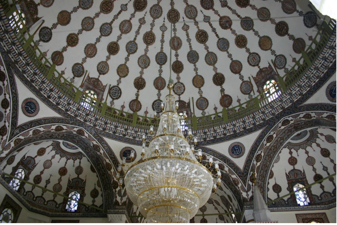
Fotoğraf 2.263: Nevşehir Damat İbrahim Paşa Cami kubbeye geçiş öğeleri
