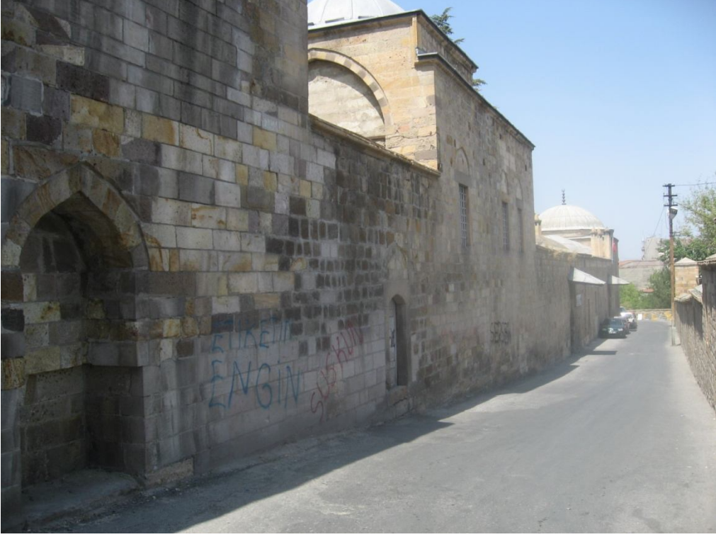
Fotoğraf 2.335: Nevşehir Damat İbrahim Paşa Sıbyan Mektebi doğu cephe
