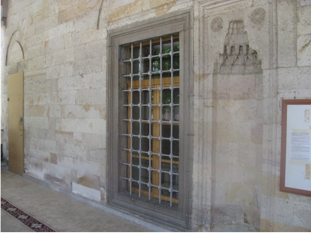
Fotoğraf 2.249: Nevşehir Damat İbrahim Paşa Cami kuzey cephe mihrabiye nişi ve pencere
