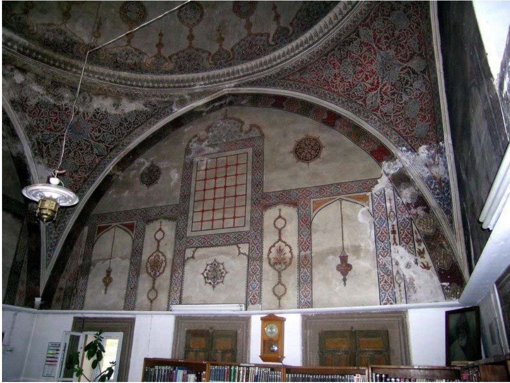
Fotoğraf 2.300: Nevşehir Damat İbrahim Paşa Medresesi dershane-kütüphane mekânı batı cephe (Mehmet Ekiz'den)
