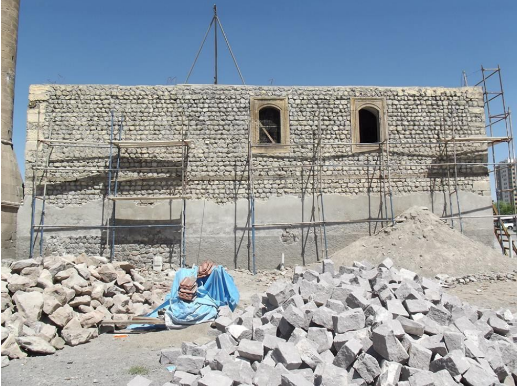
Fotoğraf 2.471: Kayseri Hasinli Cami batı cephe
