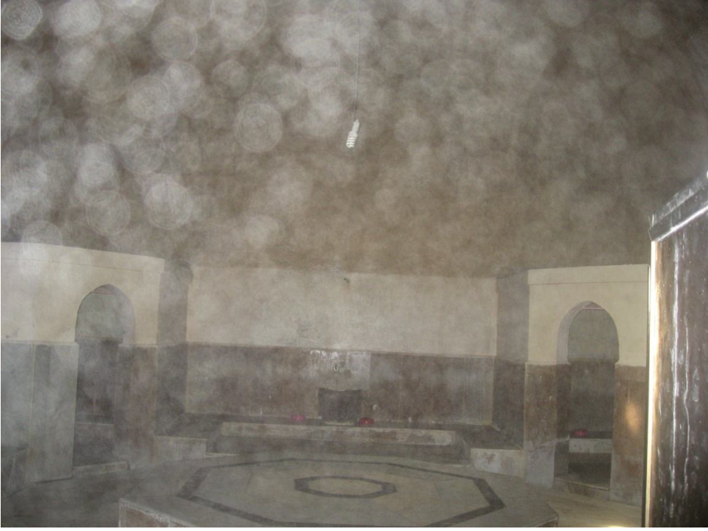
Fotoğraf 2.355: Nevşehir Damat İbrahim Paşa Hamamı sıcaklık mekanı
