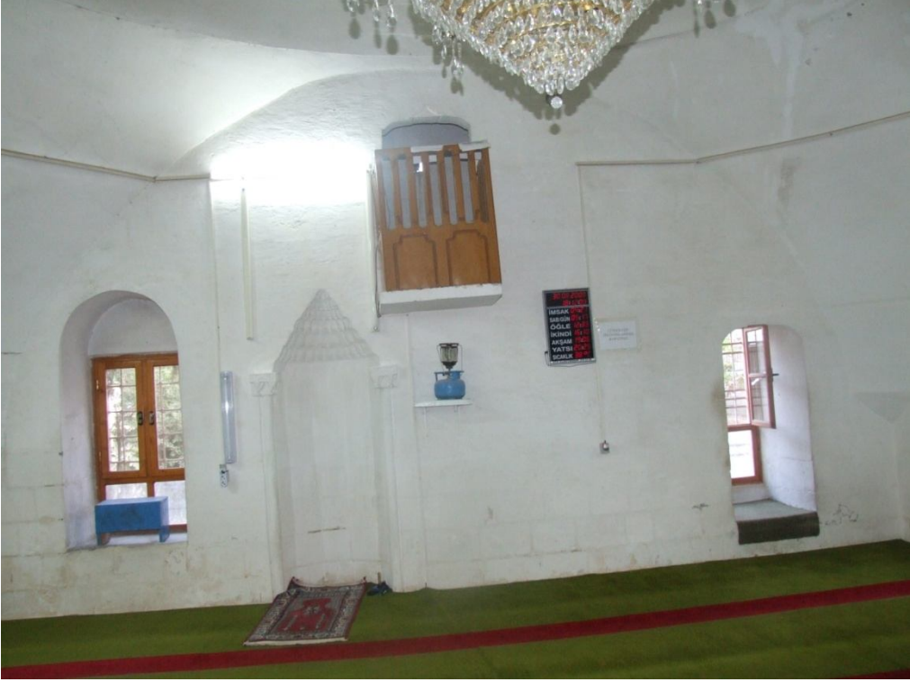
Fotoğraf 2.649: Şanlıurfa Hacı Lütfullah Cami iç mekan (güney cephe)
