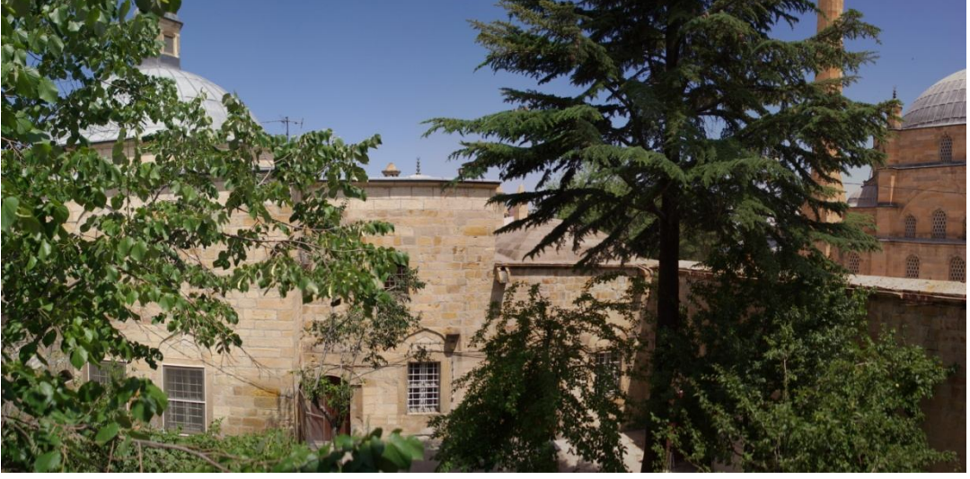
Fotoğraf 2.323: Nevşehir Damat İbrahim Paşa İmaretî avlu güneyden bakış
