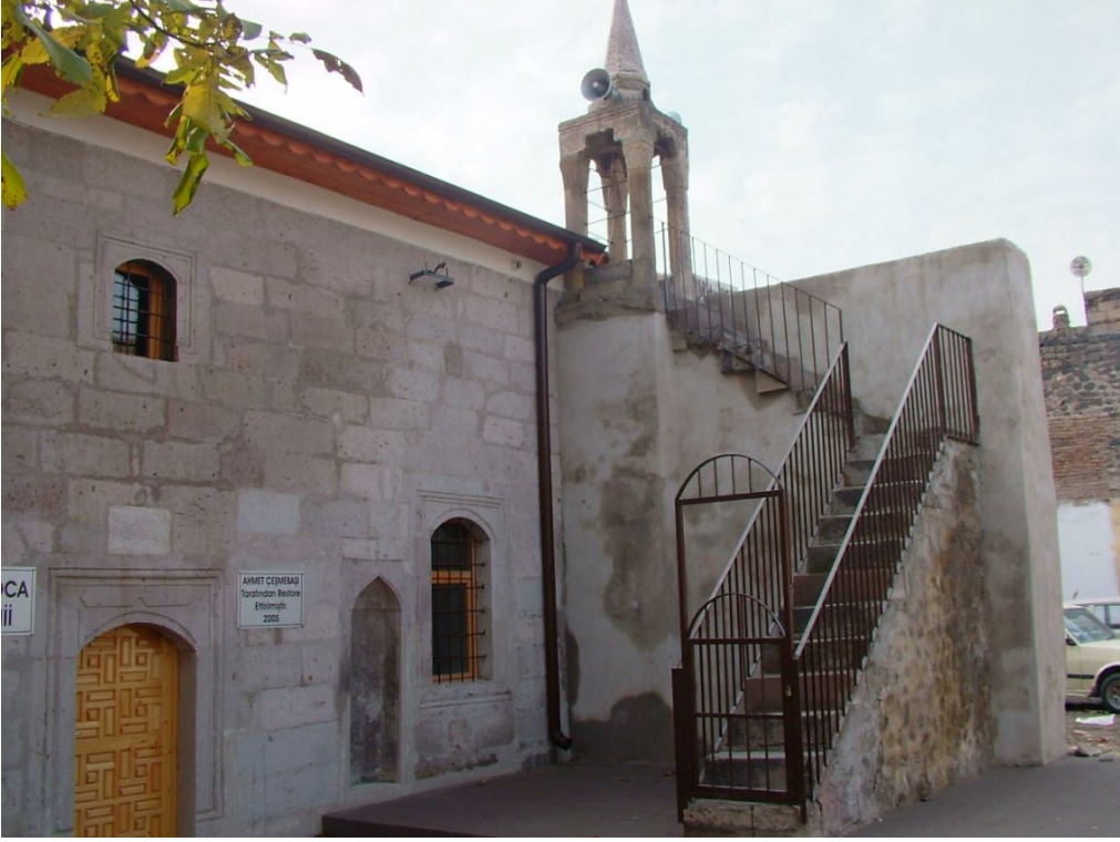
Fotoğraf 2.415: Kayseri Ali Hoca Cami köşk minareye çıkan merdivenler
