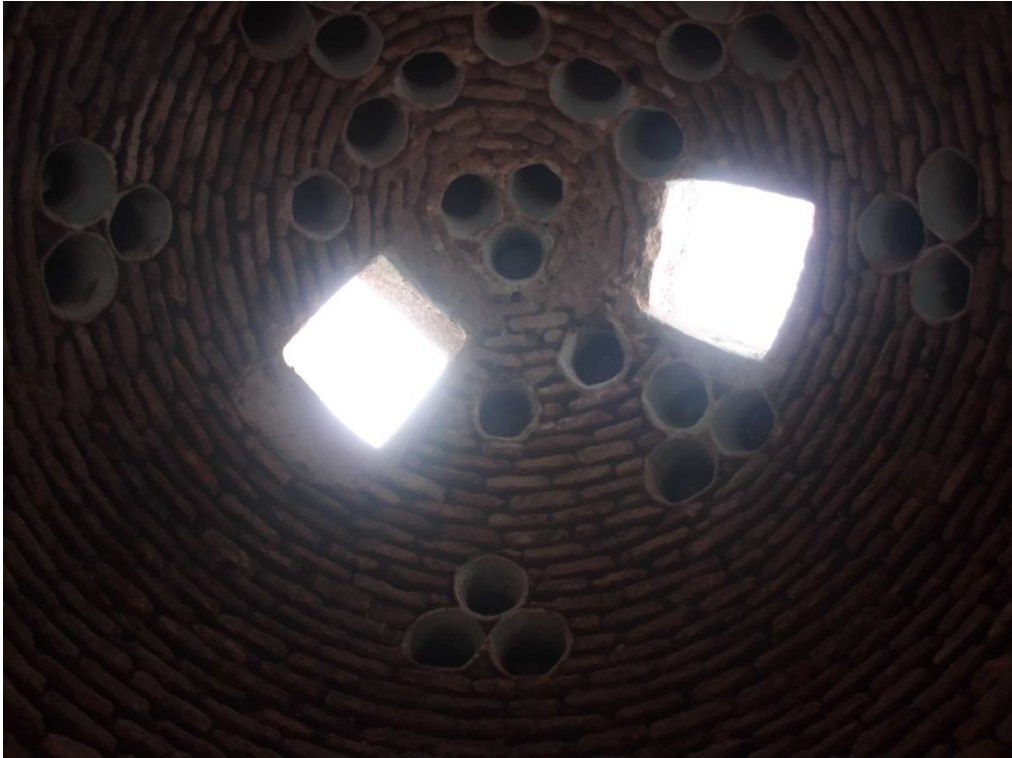
Fotoğraf 2.794: Şanlıurfa Vezir Hamamı halvet kubbelerinden örnek
