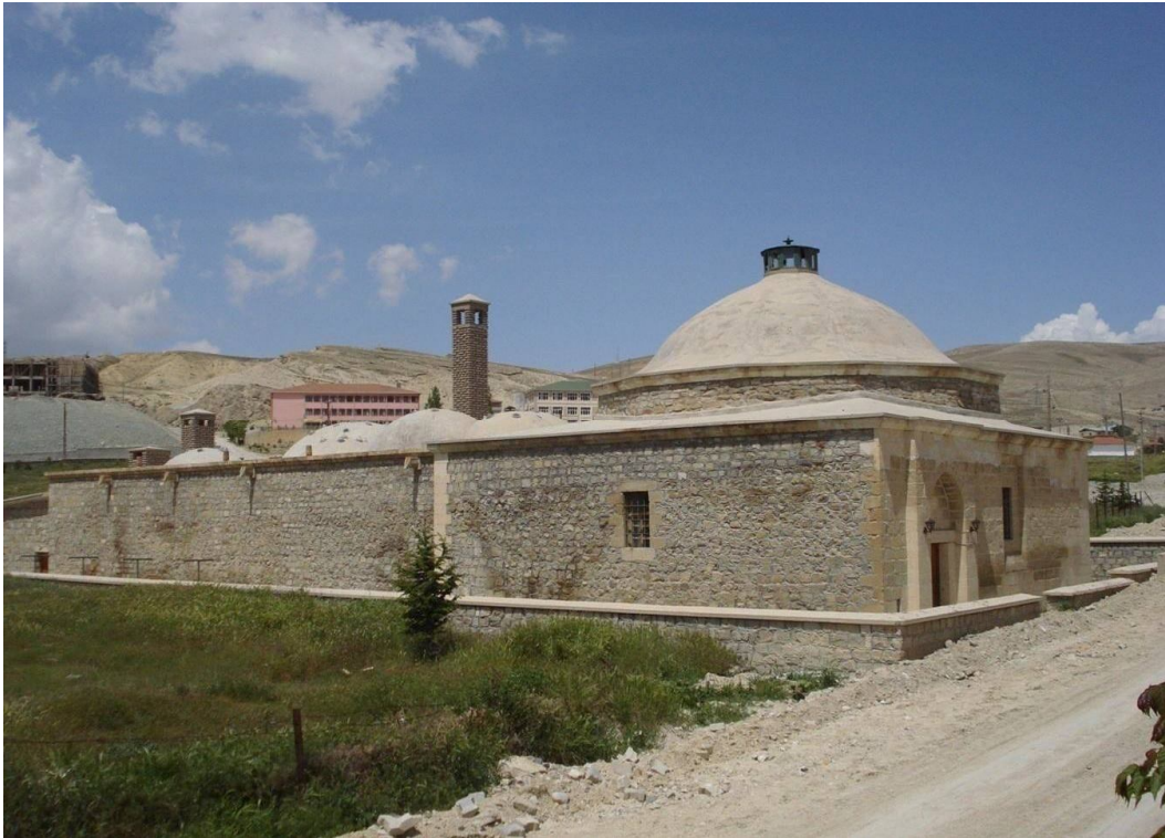
Fotoğraf 2.796: Malatya Darende Hüseyin Paşa Hamamı güney cephe
