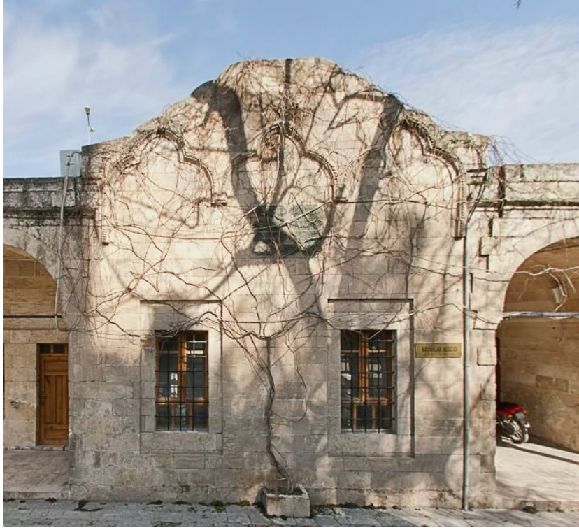
Fotoğraf 2.135: Şanlıurfa Rızvaniye Medresesi kuzey cephede yer alan dershane mekanı
