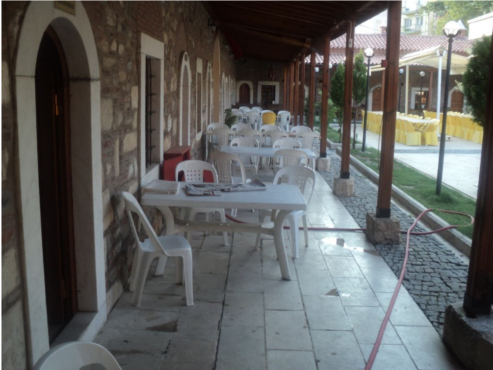
Fotoğraf 2.20: Aydın Nasuh Paşa Medresesi kuzey ve batı cepheler
