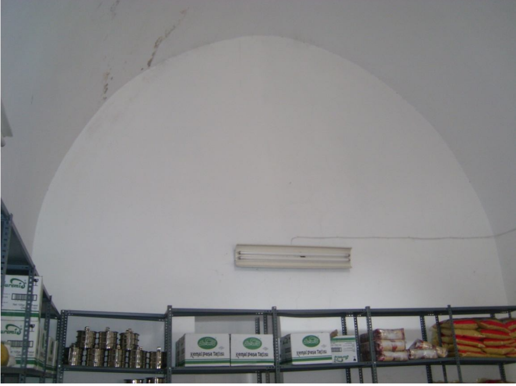
Fotoğraf 2.331: Nevşehir Damat İbrahim Paşa İmaretİ beşik tonoz örtülü mekan
