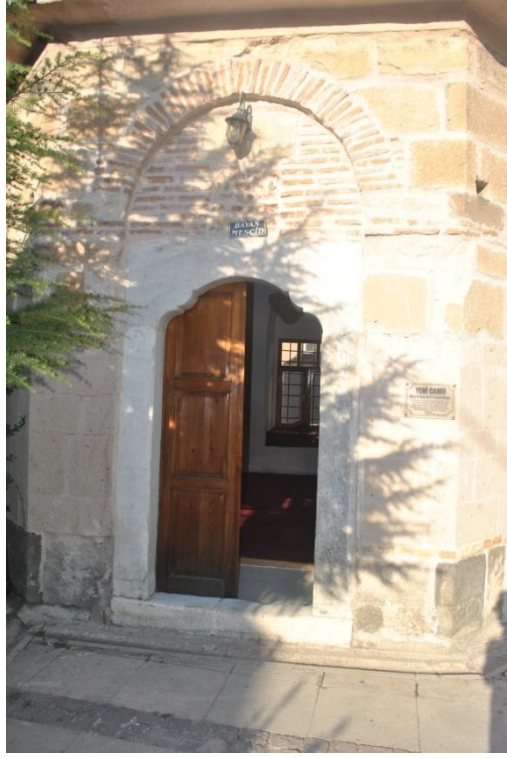
Fotoğraf 2.93: Afyon Yeni Cami Külliyesi muvakkithane giriş kapısı
