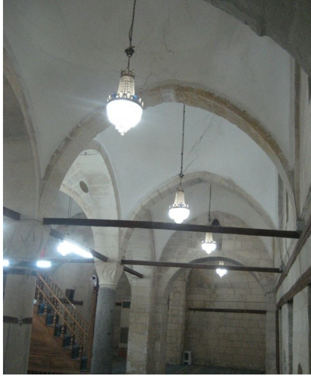
Fotoğraf 2.683: Adana Yeni Cami harim kuzey cephesi orijinal bölüm batı cephe
