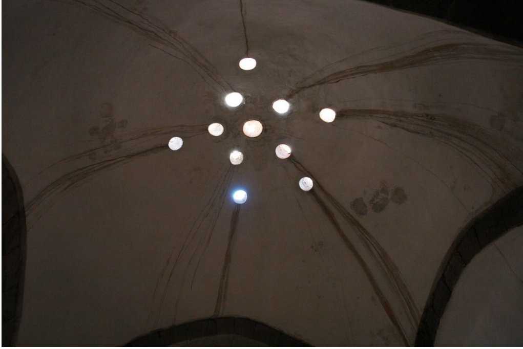
Fotoğraf 2.167: Erzurum Gümrük (Hacı Derviş) Külliyesi hamam sıcaklık mekanı fil gözleri (Vakıflar Genel Müdürlüğü arşivi 250001033-FT004-2009'nolu dosya)
