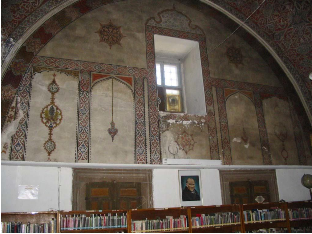
Fotoğraf 2.299: Nevşehir Damat İbrahim Paşa Medresesi dershane-kütüphane mekânı doğu cephe (Mehmet Ekiz'den)
