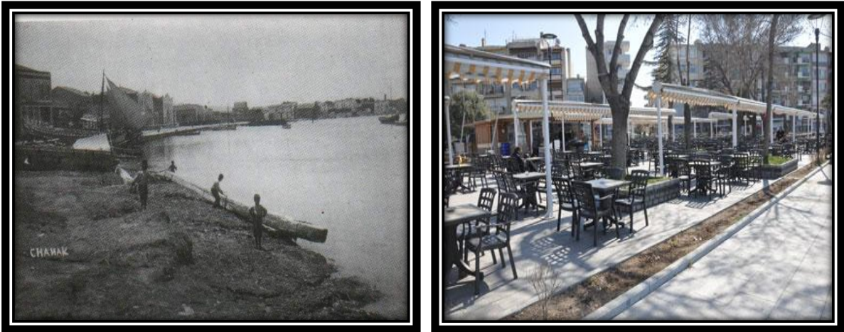
Şekil 4.43. a) Golf Çay Bahçesi (1932) b) Golf Çay Bahçesi'nin Bugünkü Durumu (Çanakkale Belediyesi 2013c) (2013)
