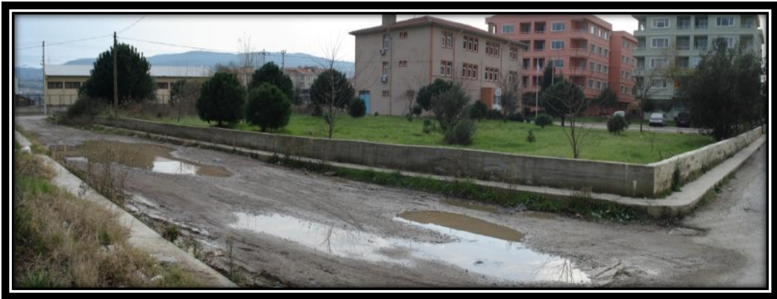
Şekil 4.32. Anadolu Hastanesi civarında üst yapı sorunları (Sağlık vd. 2012e)
