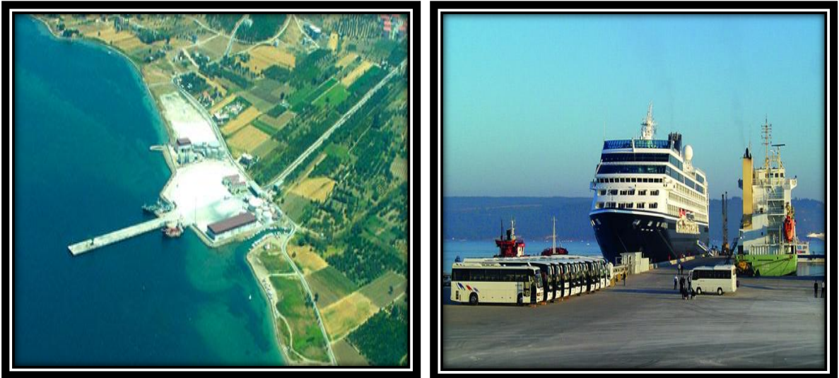
Şekil 4.27. Çanakkale Limanı (Çanakkale Liman İşletmesi 2013)
