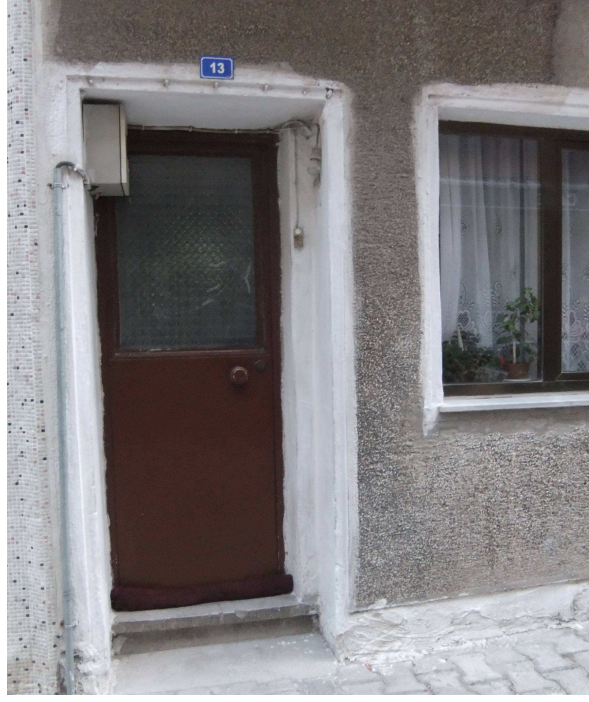
Resim60- Kapı Girişi, Çanakkale,2010
