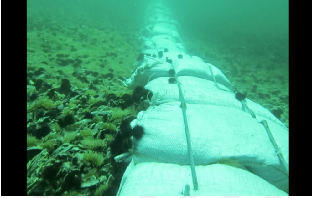
Şekil 43. Kablo hattının çapa yoluyla taranmasından korumak için yastıklama operasyonu (Özgün)
