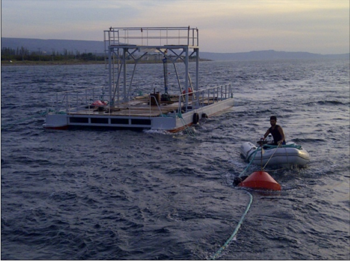
Şekil 20. Çalışma bölgesinden taşıyıcı platform fotoğrafı (Özgün)
