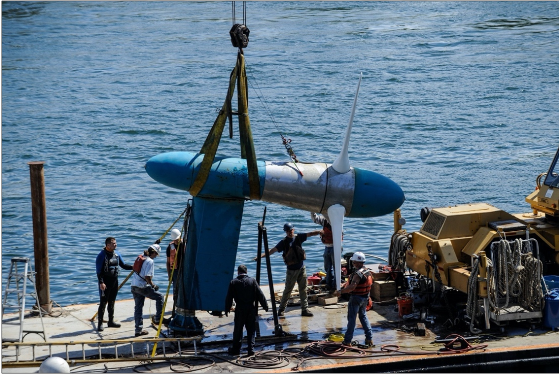
Şekil 3. Verdant Power firmasının 2012 yılında New York East River'daki türbin testleri (McGeehan, 2012).
