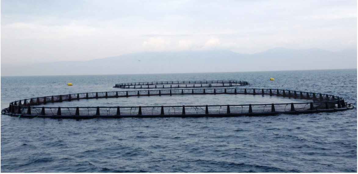
Şekil 44. HDPE (high density polyethylene, yüksek yoğunluklu polietilen) malzemeden üretilmiş açık deniz kafes görünümü
