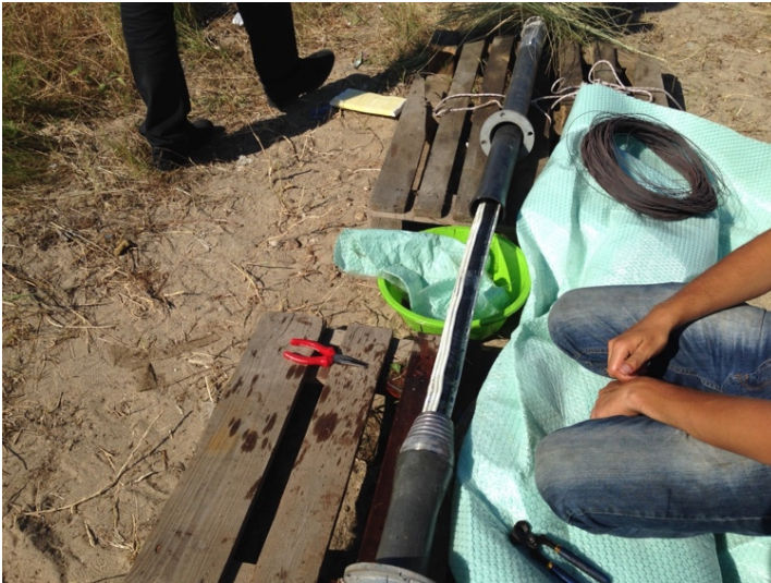
Şekil 40. Ana güç kablosu, türbin kumanda kabloları ve pnömatik hortum demetlenmesi (a,b) (Özgün)
