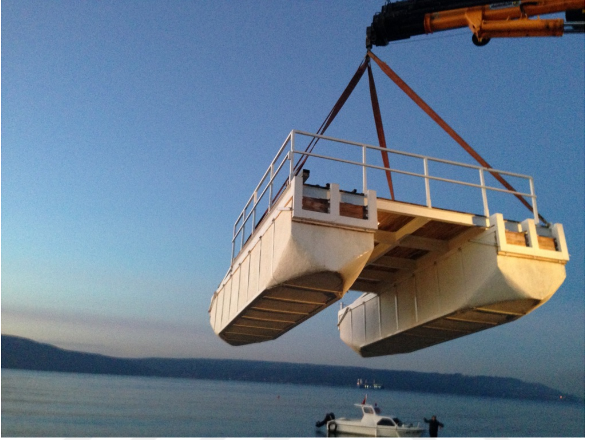
Şekil 36. Türbinin taşıyıcı servis platformunun denize indirilmesi (Özgün)
