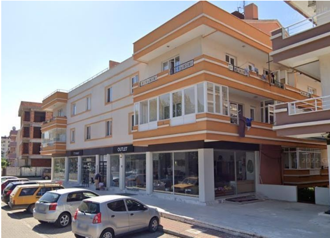
Şekil 22. Zayıf/yumuşak kat içeren bir bina
