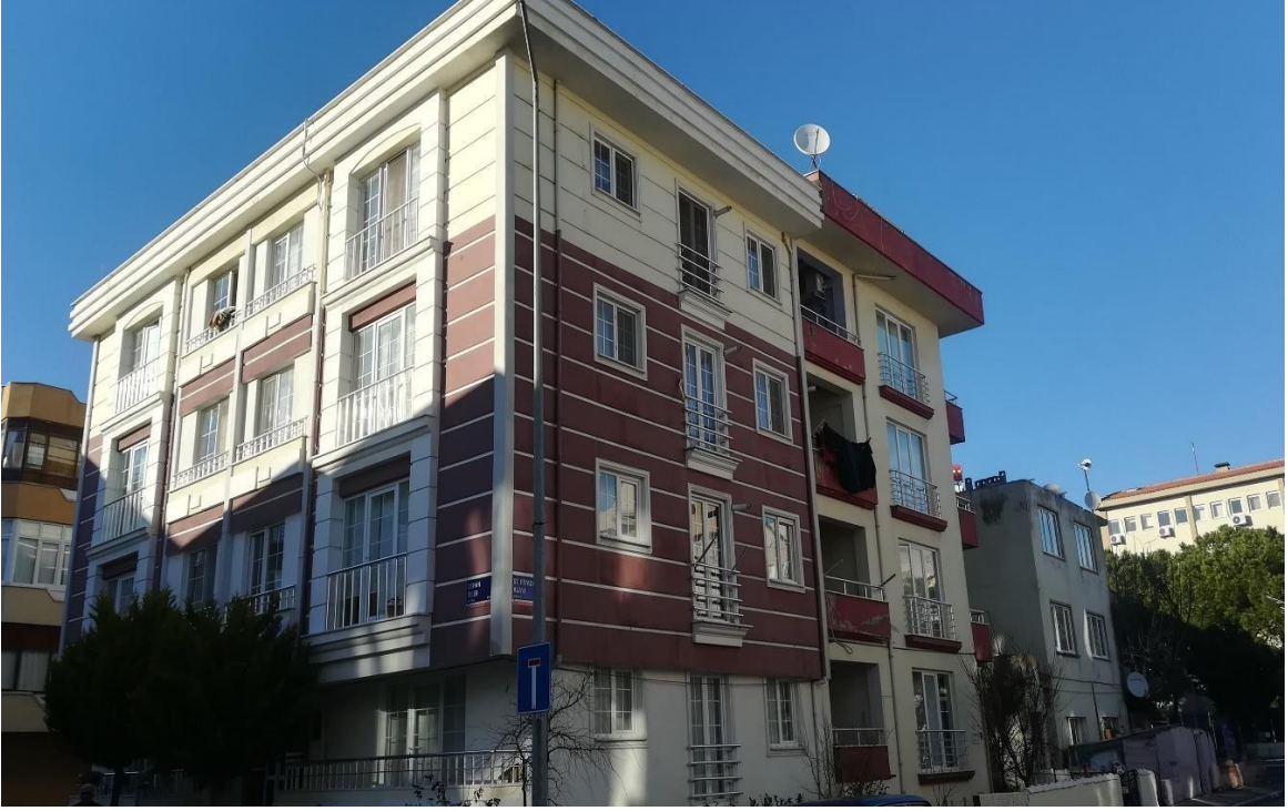
Şekil 18. Saha çalışması örnek betonarme bina fotoğrafı
