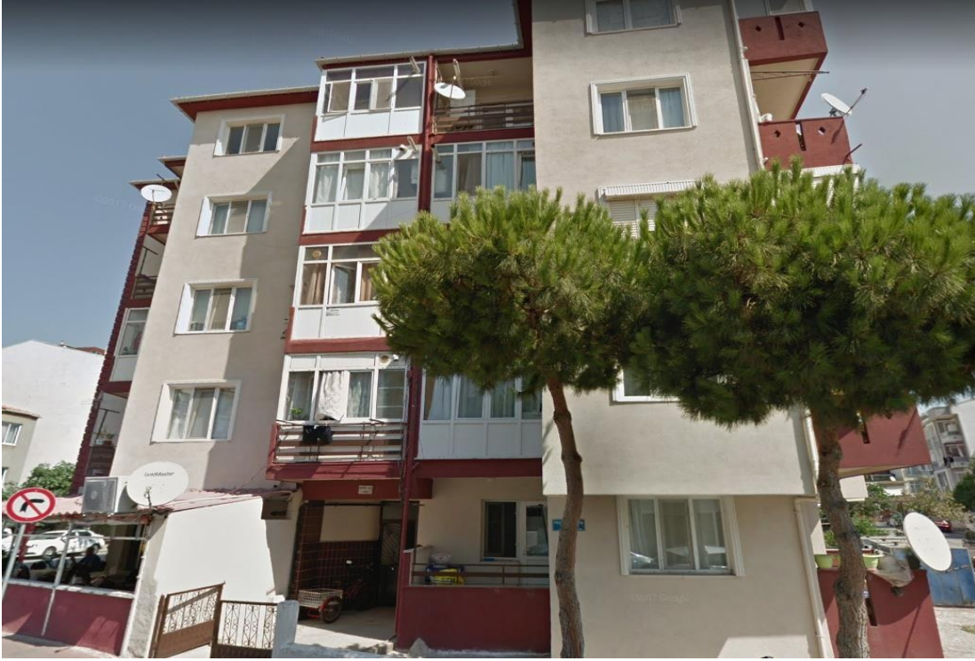
Şekil 21. Planda düzensizlik içeren bir bina
