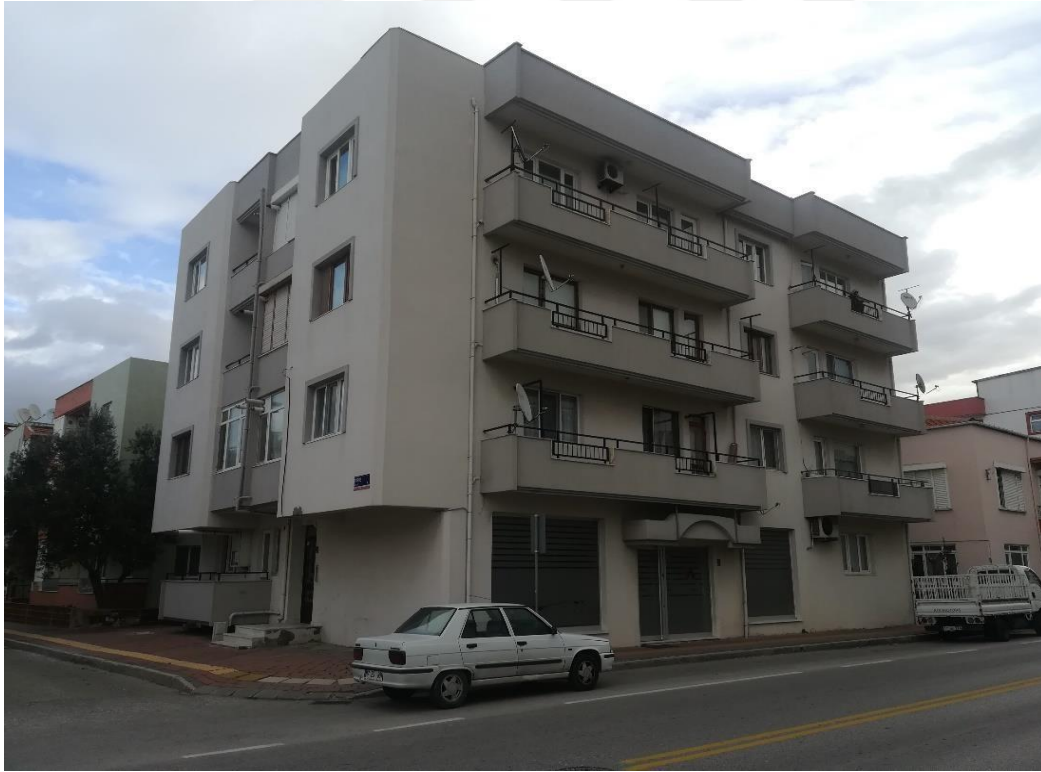
Şekil 19. Ağır çıkması olan bir bina
