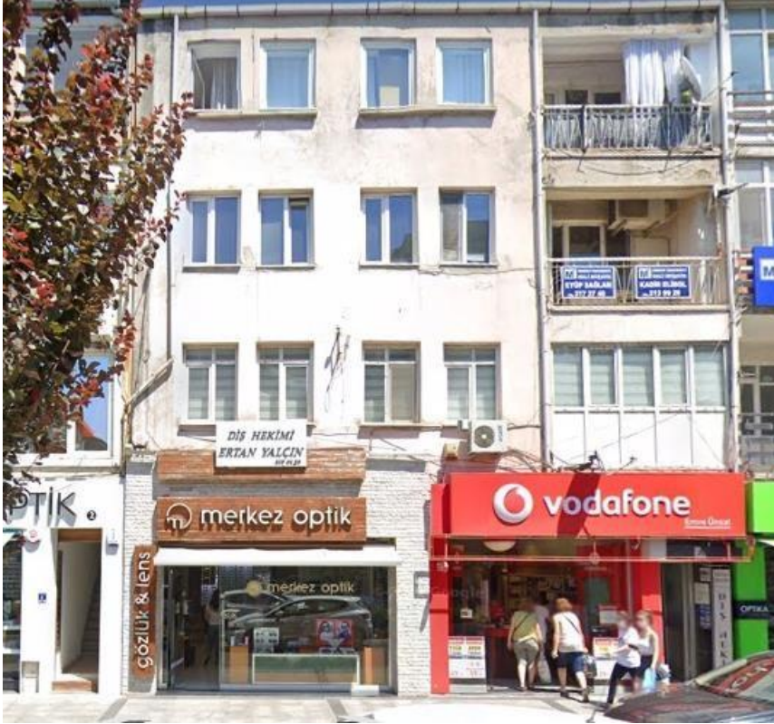
Şekil 23. Düşeyde düzensizlik içeren bina
