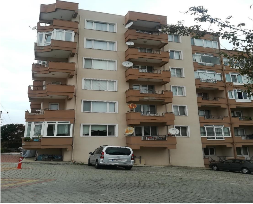
Şekil 20. Tabii zemin eğimi olan bir bina
