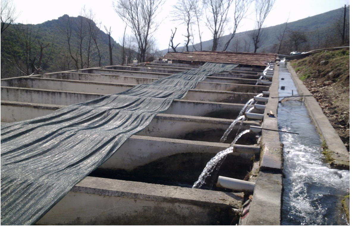
Şekil 2. Serhat alabalık üretim tesisi (İznik/BURSA)
