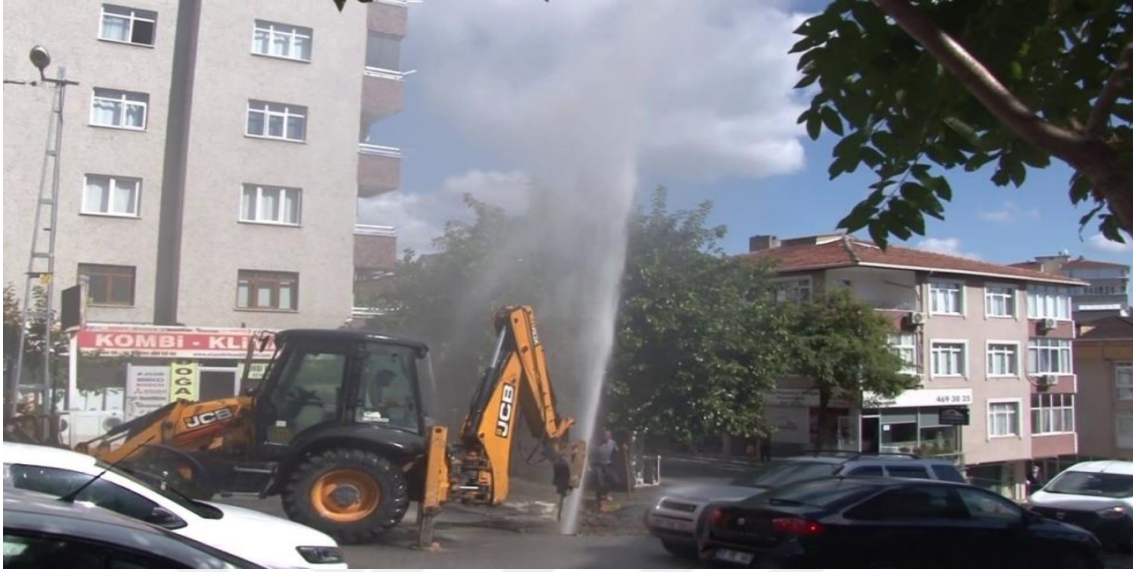
Şekil.3. ABS eksikliği nedeniyle kazı sırasında yaşanan bir borunun patlaması (URL2)
