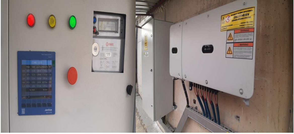
Şekil 34. Sistemde kullanılan inverter ve kontrol panosu
