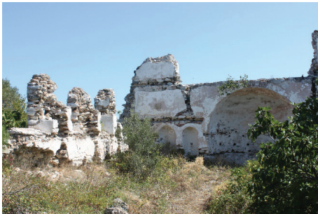
Res.9: Kilise, içten görünüş.
