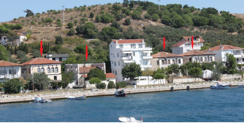
Res. 32: Aynı yerin günümüzdeki durumu. Yedi kardeşler olarak bilinen evlerden dördü kısmen mevcut durumda.
