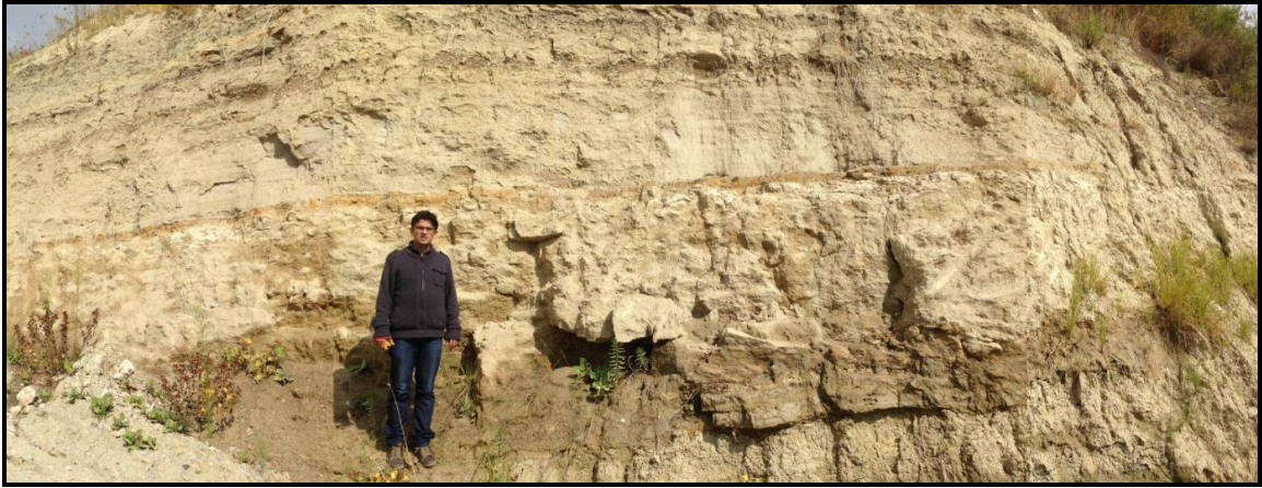
Şekil 29. Çanakkale viyadüğünün üstünde gözlenen İntepe üyesine ait kumtaşları ve kumlu kireçtaşları (UTM: 443838 D, 4430650 K)
