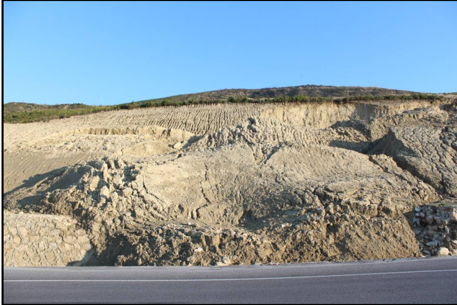
Şekil 27. Güzelyalı-İntepe yolunda üzerinde heyelan hareketinin gerçekleştiği Tekkedere üyesine ait iyi çimentolanmamış kumtaşlarının görünümü (UTM: 444317 D, 4431512 K)
