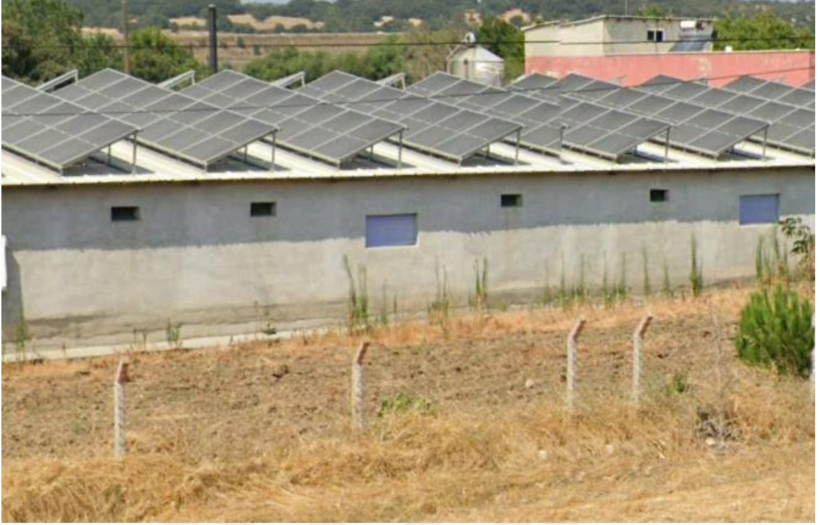
Şekil 5. Çatı bakışından farklı açıda yerleştirilmiş güneş panelleri
