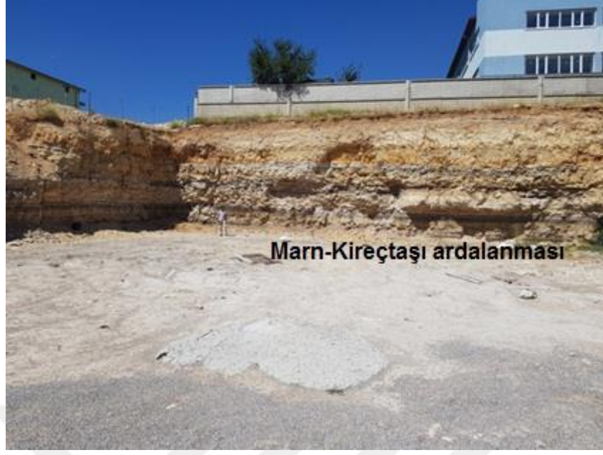
Şekil 19. Beyşehir Sanayii ölçülü stratigrafik kesitinde organikçe zengin marn-kireçtaşı ardalanması (Bakış Yönü: KD-GB).
