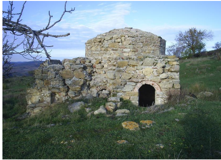
Res.18. Burhanlı Hamamı, sıcaklığın güney cephesi
