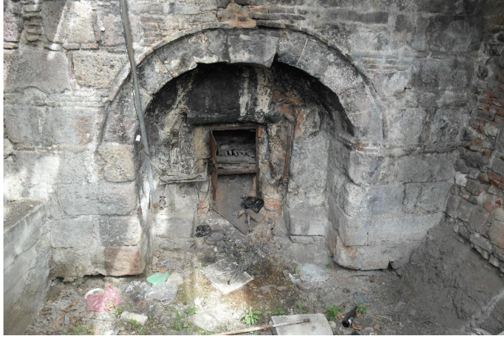
Res.8. Bayramiç Çarşı Hamamı, külhanda ocağın cephesi
