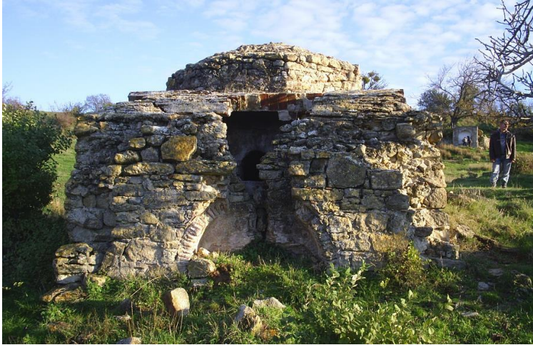
Res.19. Burhanlı Hamamı, ocak cephesi
