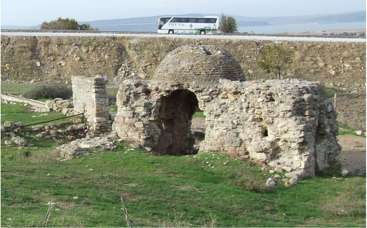
Res.39. Özbek Köyü Hamamı, güneydoğu cephe
