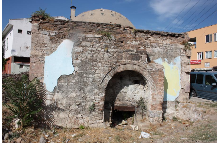
Res.16. Geyikli Hamamı, ocak cephesi
