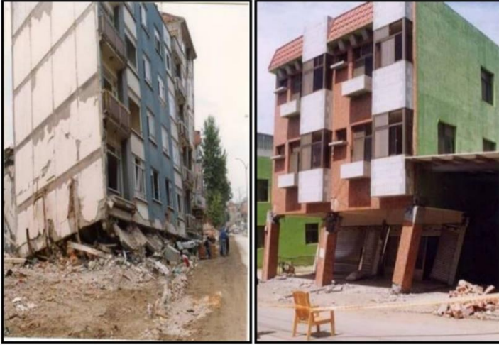
Şekil 5. Yumuşak kat etkisi. (Ertürkmen ve Çağatay, 2016)
