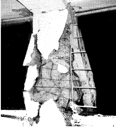
Şekil 10. Kısa kolon etkisi. (Anderson, 1987)
