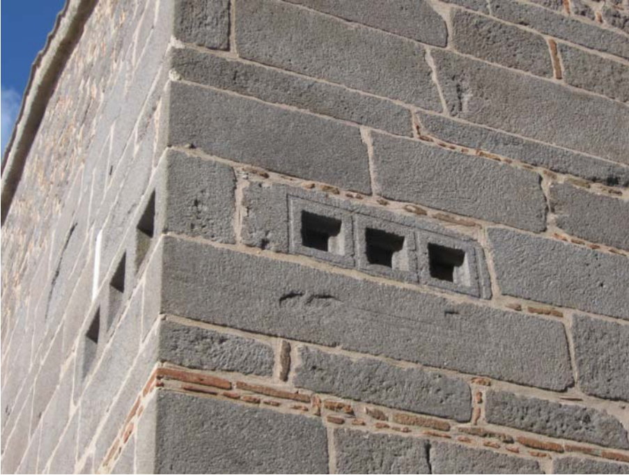
Şekil 22: Athena Tapınağı'nın Murad Hüdavendigâr Camisi duvarlarında kullanılan tavan kaset blokları (Erdem Salcan - 2008)
