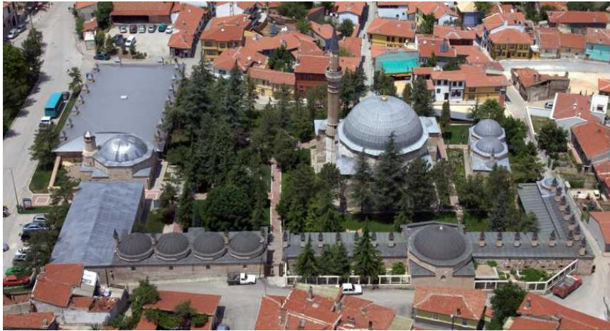
Resim 65: Eskişehir Kurşunlu Külliyesi genelgörünümü (Eskişehir Valiliği)
