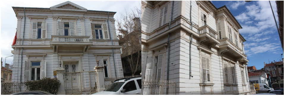
G. 2: Doğu cephe (M. Dündar, 2020)
