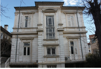
G. 4: Batı cephe (M. Dündar, 2020)
