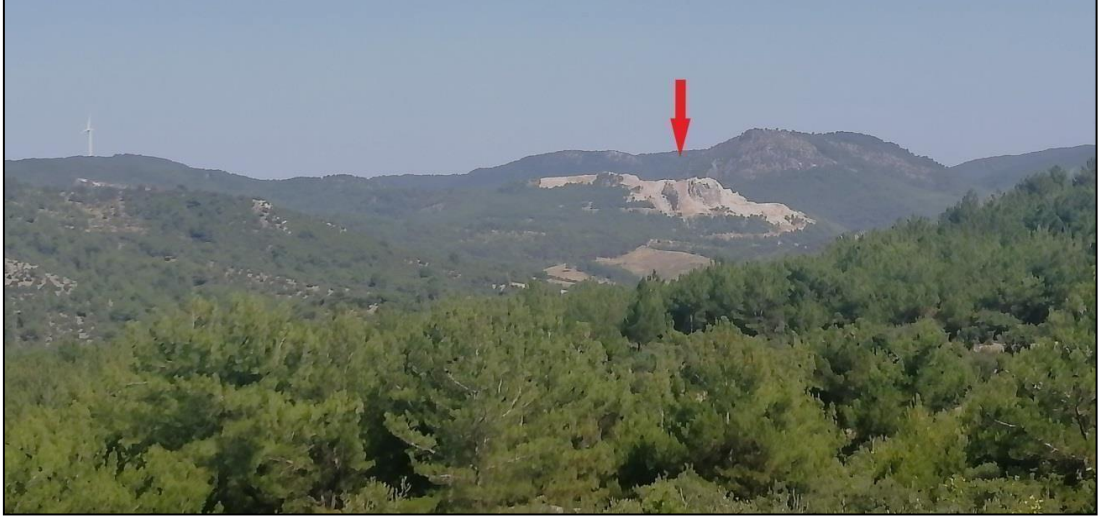
Resim 24. Kazdağı yamaçlarında açılan ve yamaç dengesini bozan taş ocağının görünümü
