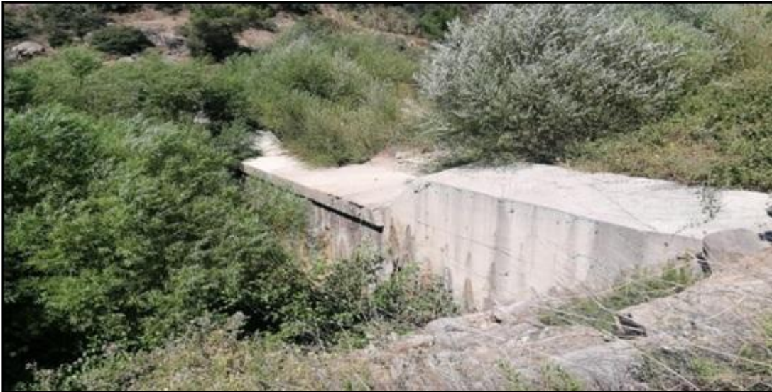
Resim 26. Taşkın riskini azaltmak için Babadere yatağında yapılan bentin görünümü
