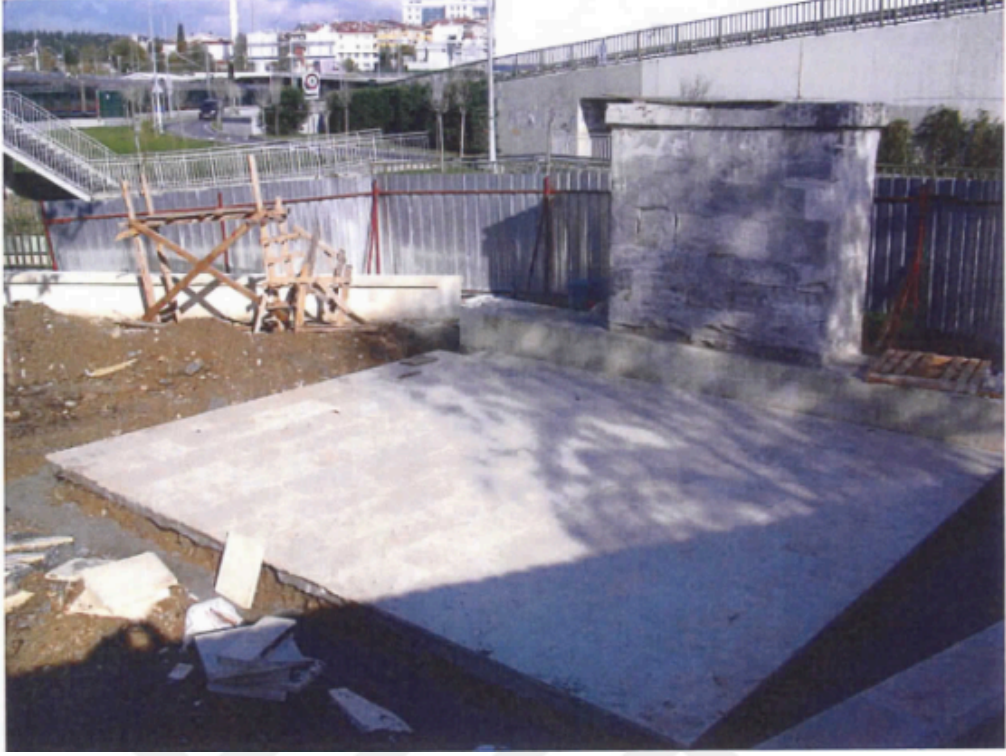
Resim 82: Kadıköy Ayrılık Çeşmesi 2009 Restorasyon Çalışmaları (İstanbul 5 No'lu Koruma Kurulu).
