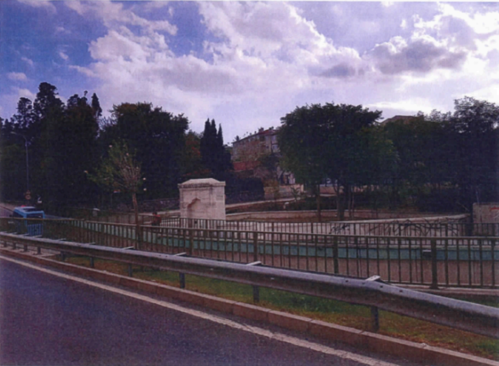
Resim 83: Kadıköy Ayrılık Çeşmesi 2009 Restorasyon Çalışmaları (İstanbul 5 No'lu Koruma Kurulu).
