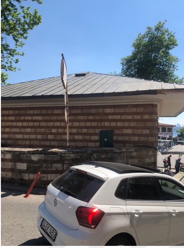
Resim 74: Beykoz İshak Ağa (On Çeşme) Çeşmesi Su Deposu Almasıık Duvarı.
