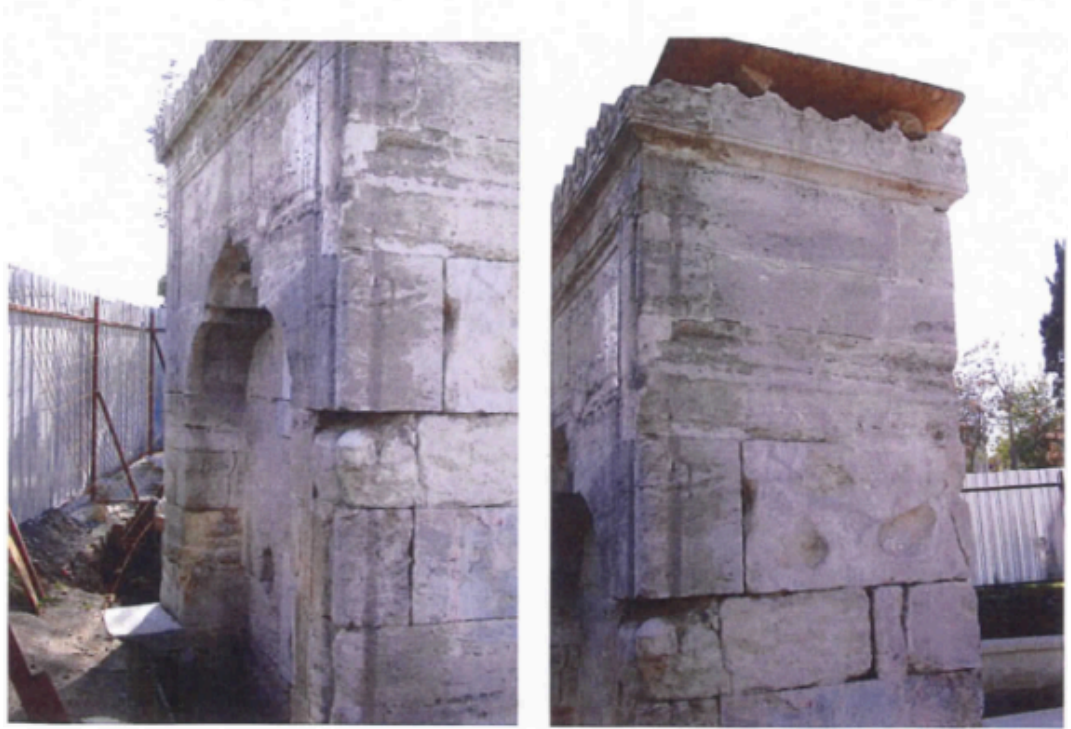
Resim 81: Kadıköy Ayrılık Çeşmesi 2009 Restorasyon Çalışmaları (İstanbul 5 No'lu Koruma Kurulu).
