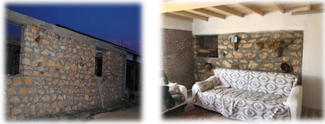
Şekil 23 Yeniden Onarılan Taş Bina ve İkinci Katında İnşa Edilen Ahşap Kat
