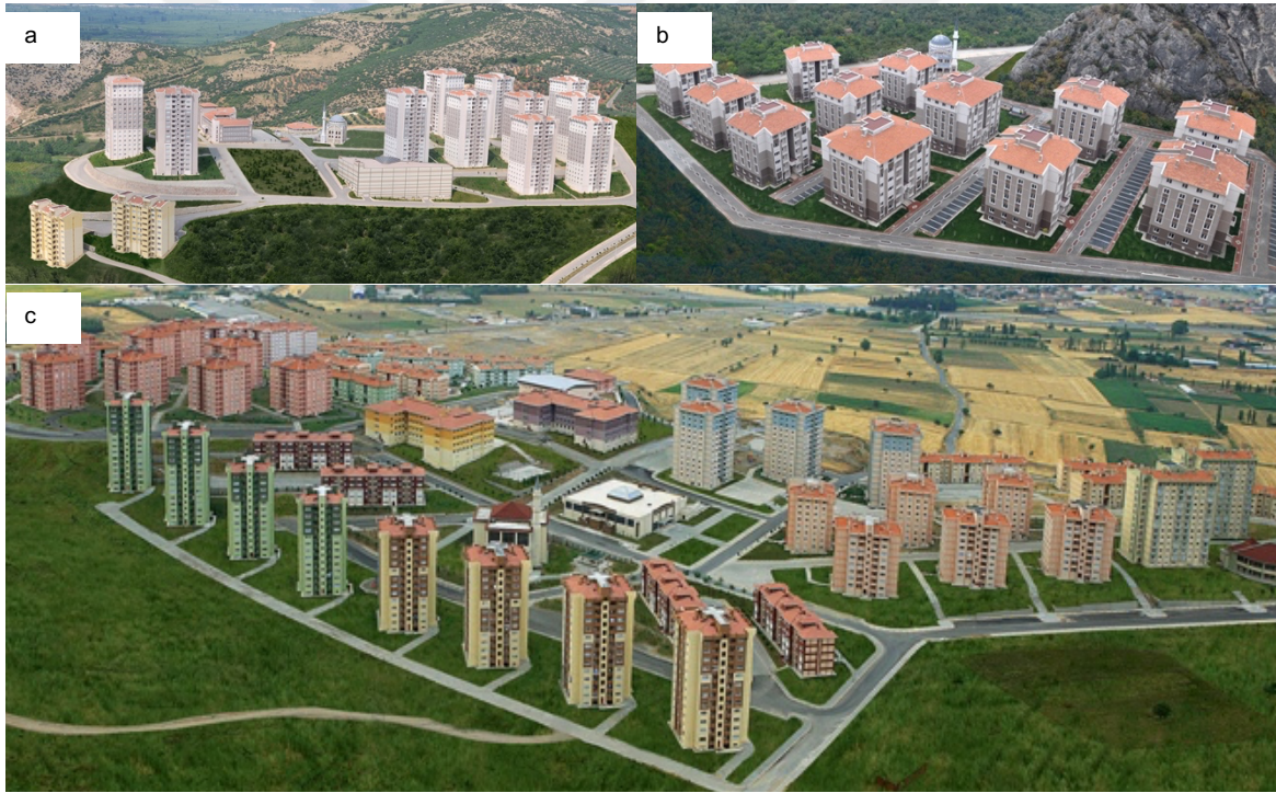
Şekil 2. A-Bursa, Kestel toplu konut uygulaması, b- Amasya sosyal konut uygulaması, c- Balıkesir, Ayşebacı sosyal konut projesi ( https://www.toki.gov.tr/uygulama/illere-gore-uygulamalar )
