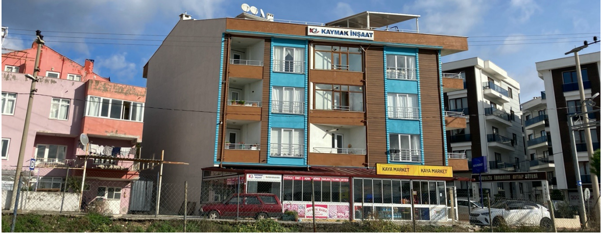
Şekil 42. Kaymak İnşaata ait bina görseli 430 ada 5 parsel
