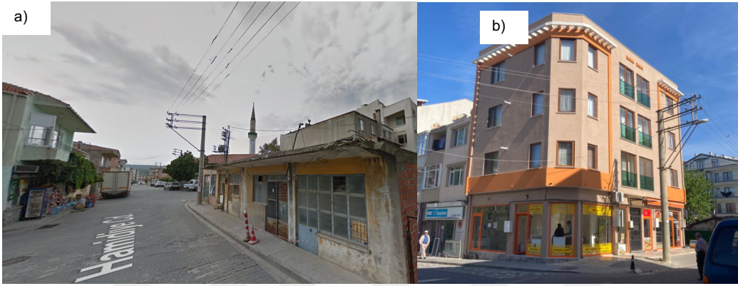
Şekil 41. Kaymak İnşaata ait bina görseli 395 ada 6 parsel, a)eski, b)yeni
