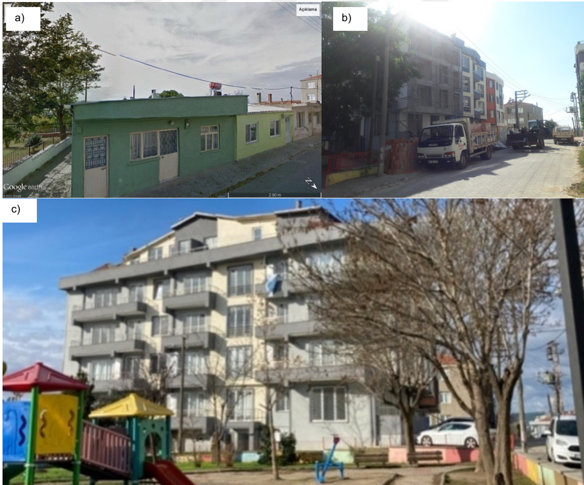
Şekil 40. 433 ada 12 parsel a) 2014 b) 2019 c)2022
