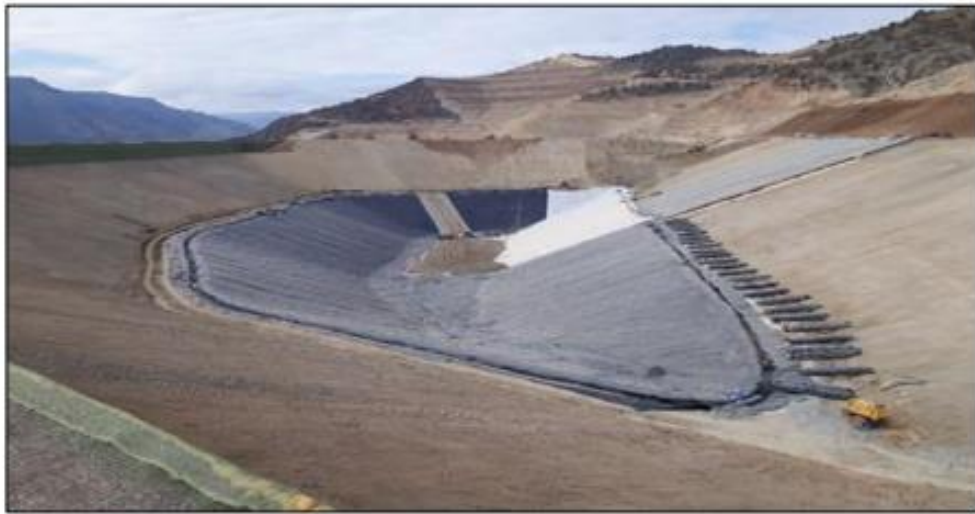
Şekil 10. Jeomembran kaplama işlemi (Demirer, 2019)
