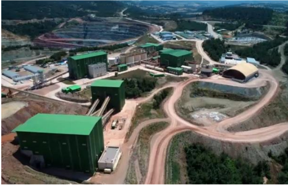
Şekil 26. Zenginleştirme tesisi genel görünümü (Youtube, 2023)
