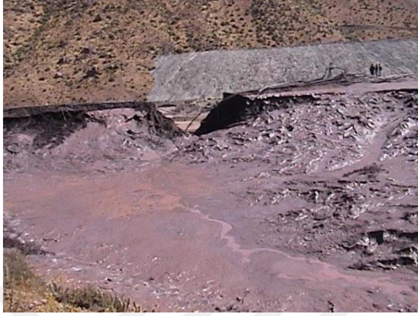
Şekil 7. Carre Negro (San Diego) Şili akma sonucu meydana gelen zarar (Mitto Danışmanlık, 2017)
