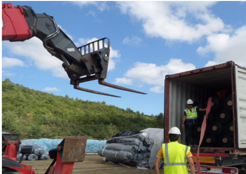
Şekil 42. Jeomembranların uygun bir şekilde depolanması (Mitto Danışmanlık, 2017)
