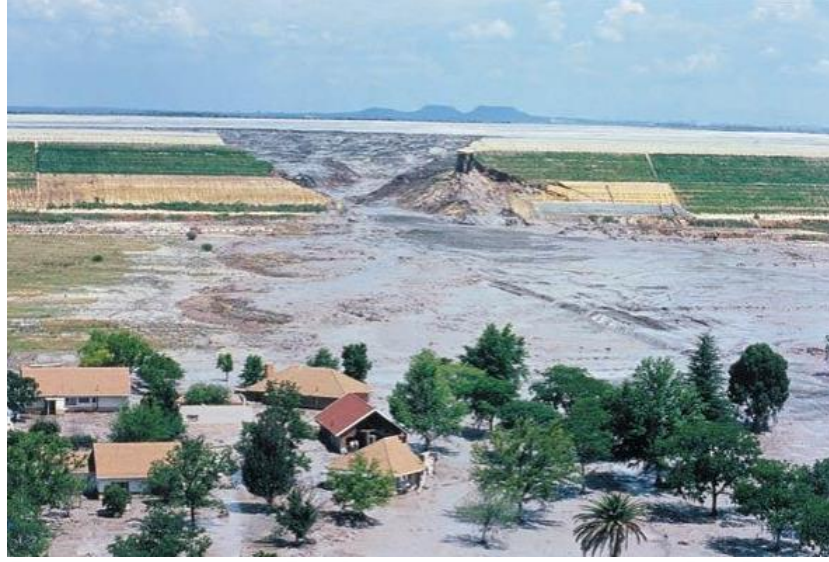
Şekil 8. Marriespruit kuru atık tesis kazası (Mitto Danışmanlık, 2017)
