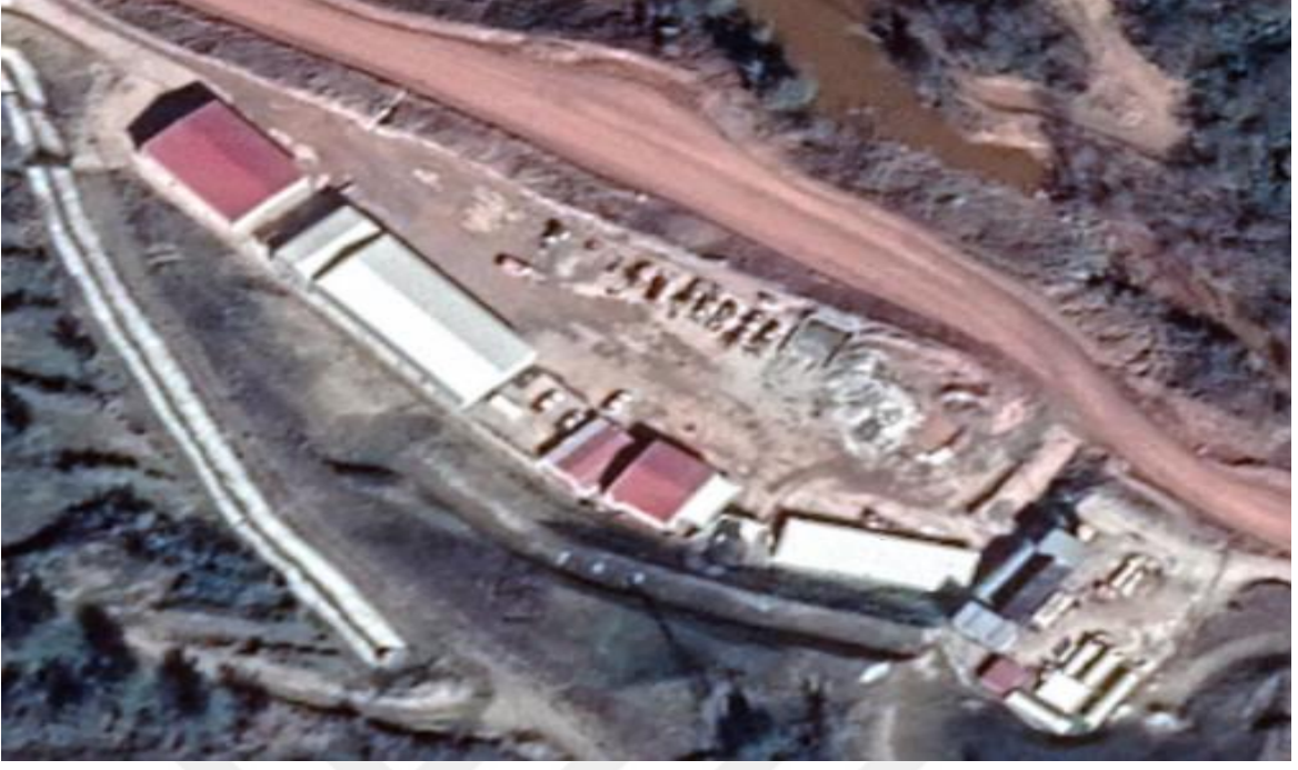
Şekil 19. Yer altı-Portal bölgesi genel görünümü (Google Earth, 2021)
