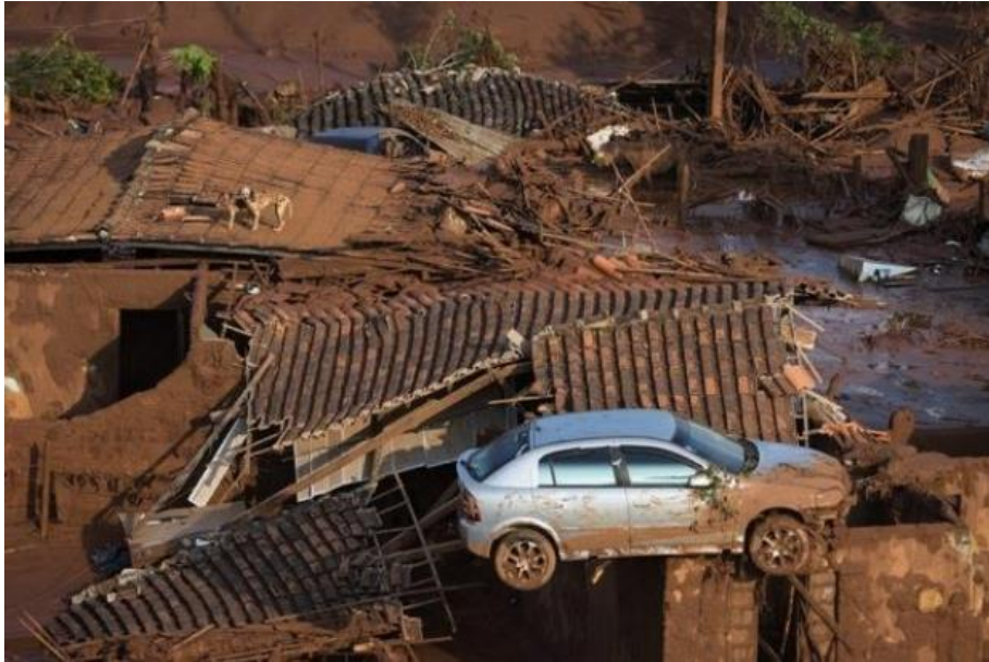
Şekil 9. Brezilya (Samarco) akma sonucu etkilenen alan (Mitto Danışmanlık, 2017)
