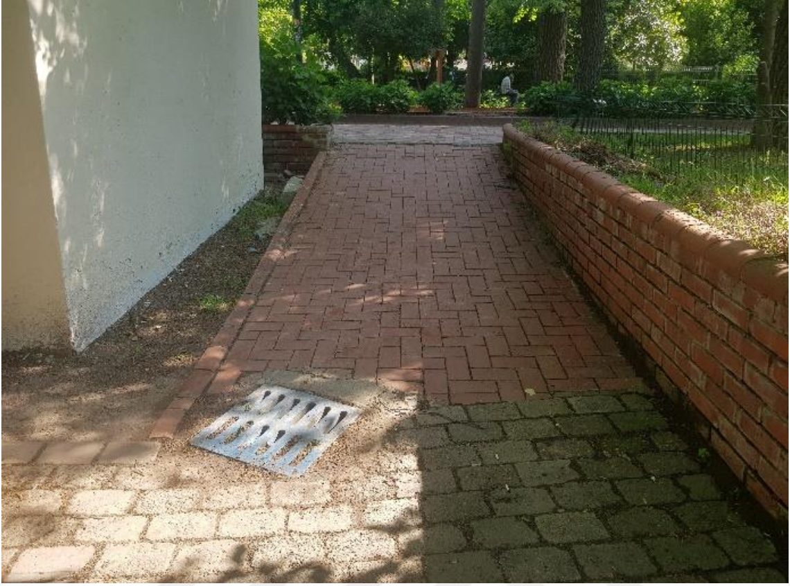
Şekil 16. Rampa Yol Birleşiminde Mazgal Bulunan Rampa
