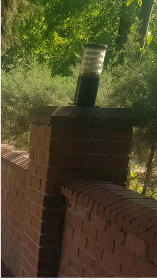
Şekil 26. Duvar Üzeri Aplik Aydınlatması
