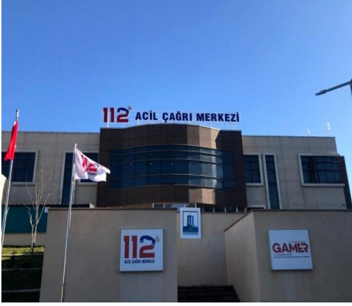
Şekil 3. 112 Acil Çağrı Merkezi dış yapısı
