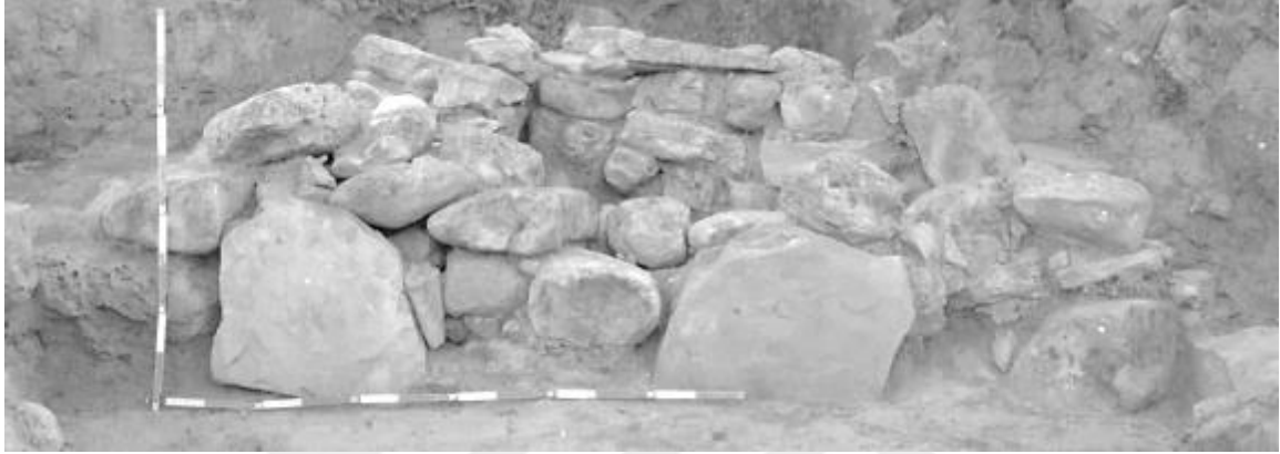
Şekil 3.49. 52 no'lu duvarın kuzeyden görünümü.
